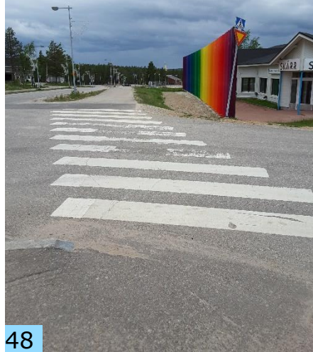
Suojatien reunatuki puuttuu ja suojatie on vino Honkapolulla. Suojatie on pitkä.
