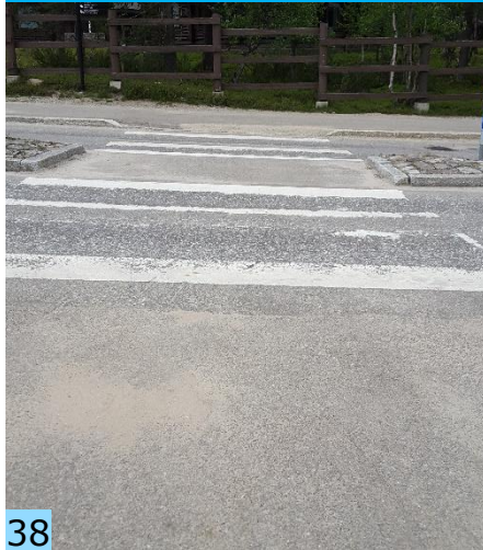
Suojatien reunatuki puuttuu toiselta puolelta Saariseläntiellä.
