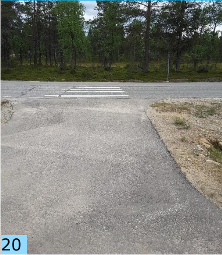
Suojatien reunatuki puuttuu Saariseläntiellä.
