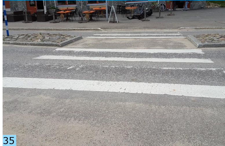
Saariseläntiellä suojatien reunatuki puuttuu toiselta puolelta. Toisella reunalla luiska on jyrkkä.
