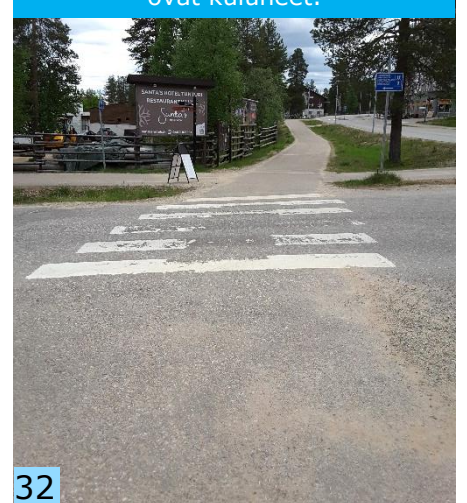
Suojatien reunatuki puuttuu Lutontiellä, suojatiemerkinnyt ovat kuluneet.
