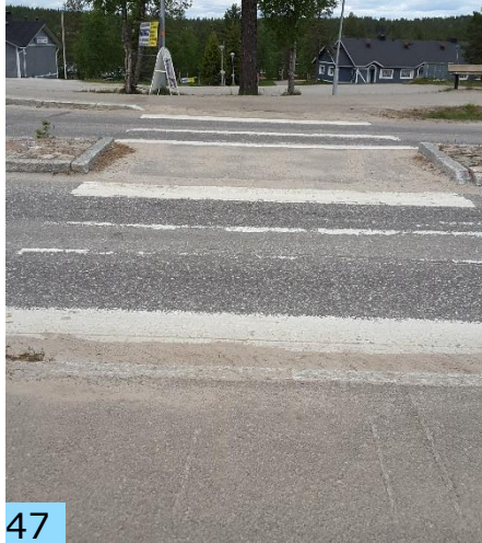
Suojatien yläreuna on liian jyrkkä Saariseläntiellä.
