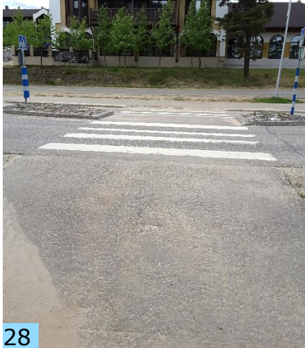
Suojatien reunatuki puuttuu Saariseläntiellä.
