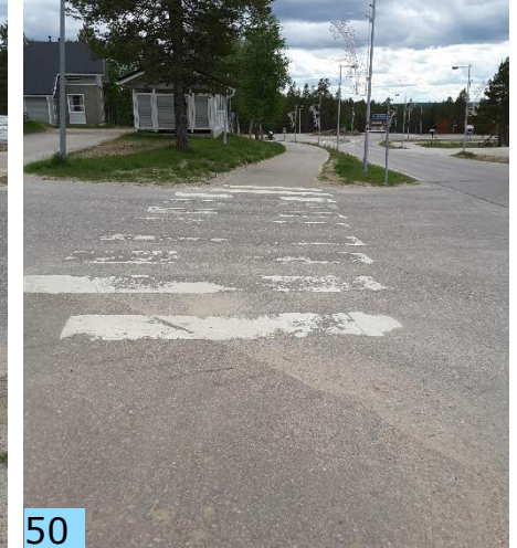
Suojatien reunatuki puuttuu Jokostiellä, suojatiemerkinnyt ovat kuluneet.
