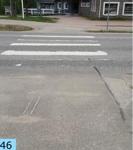
Suojatien reunatuki puuttuu Saariseläntiellä, suojatiemerkinnyt ovat kuluneet.
