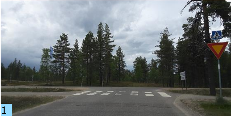
Suojatien reunatuki puuttuu ja suojatiemerkinnyt ovat kuluneet Saariseläntiellä.
