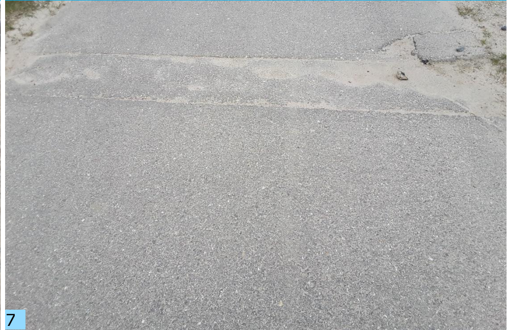
Routavaurio väylällä Kiveliöntien varrella.
