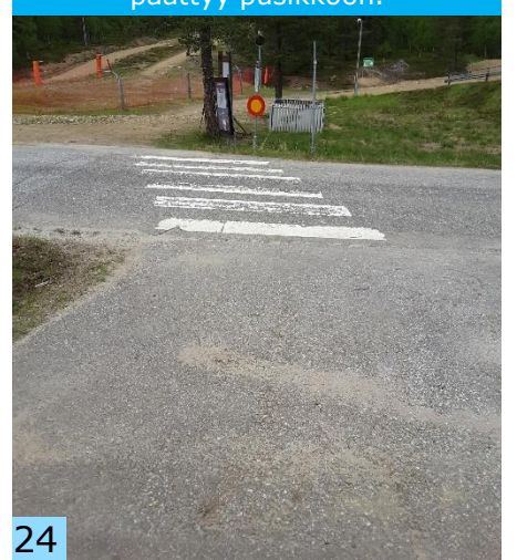
Suojatien reunatuki puuttuu Lutontiellä, suojatiemerkinnyt ovat kuluneet.
