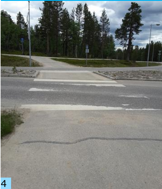
Suojatien reunatuki puuttuu ja suojatiemerkinnyt ovat kuluneet Saariseläntiellä.
