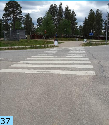
Suojatien reunatuki puuttuu Lutonttiellä. Suojatie on pitkä.
