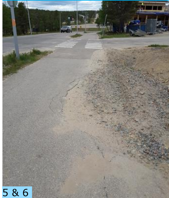
Asfaltti on irti ja suojatien reunatuki puuttuu Kiveliöntiellä.
