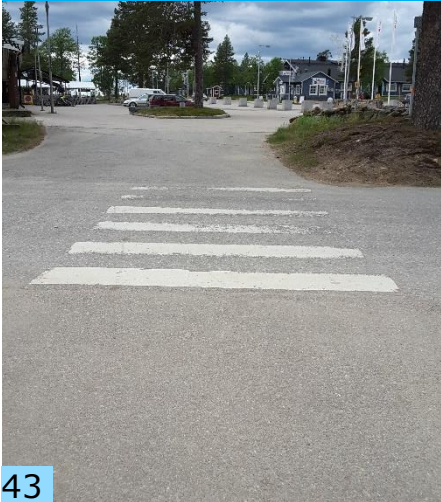
Suojatien reunatuki puuttuu Saariseläntiellä, suojatiemerkinnyt ovat kuluneet.
