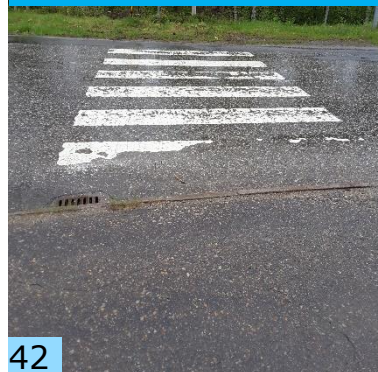
Sairaalantiellä reunatuki on liian korkea toiselta puolelta, toinen puoli johtaa pusikkoon.
