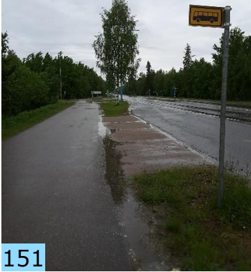
Pysäkkiä ei ole korotettu Ivalontien varrella, vesi seisoo pysäkin alaosassa.
