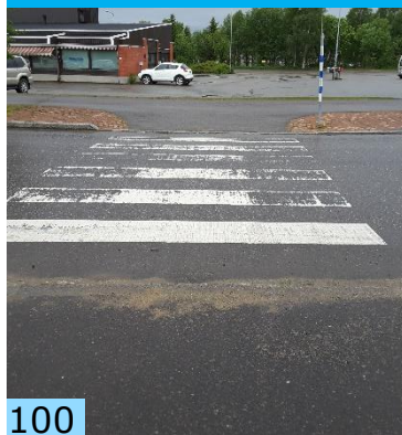
Reunatuki on liian korkea Piiskuntiellä, merkinnät ovat kuluneet.
