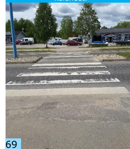
Suojatiellä ei ole reunatukea Ivalontien varrella. Merkinnät ovat kuluneet.
