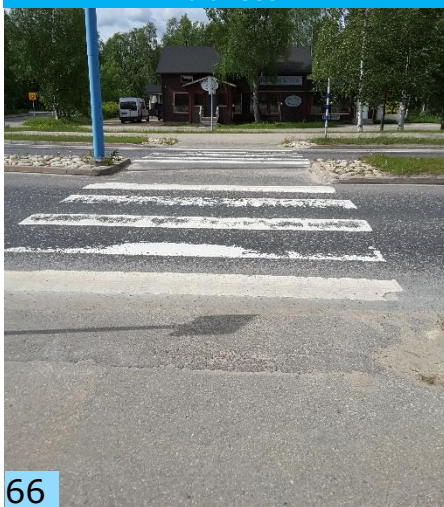
Suojatiellä ei ole reunatukea Ivalontien varrella, merkinnät ovat kuluneet.
