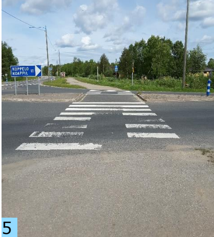
Suojatiellä ei reunatukia Koppelontiellä, suojatiemerkinnot kuluneet.
