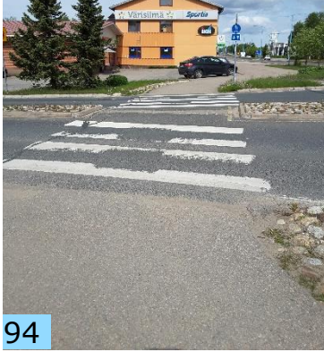
Suojatielle ei ole reunatukea Kaamostiellä, merkinnät ovat vinot.
