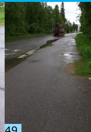
Routavaurioita väylällä Kaamostien varrella. Sivukaltevuus paikoin yli 3 %.
