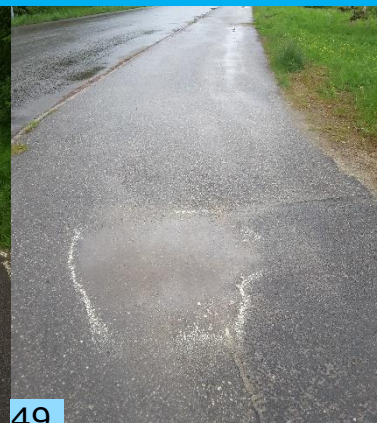
Routavaurioita väylällä Kaamostien varrella. Sivukaltevuus paikoin yli 3 %.
