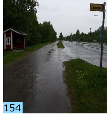
Pysäkkiä ei ole korotettu Ivalontien varrella, kuivatusongelma.
