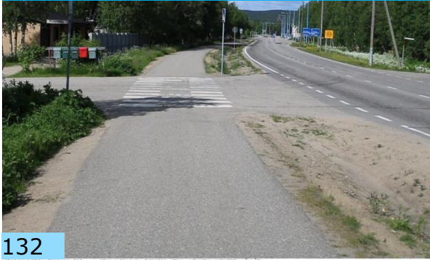
Suojatien reunatuki puuttuu Palolantiellä.
