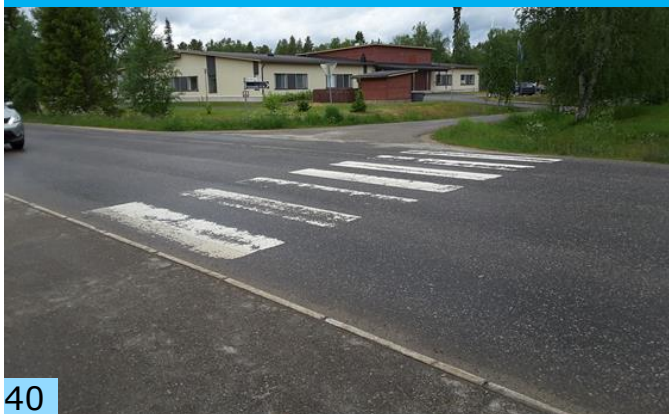
Suojatien reunatuki on liian korkea/jyrkkä Sairaalantiellä. Suojatie ei pääty jalankulun väylälle.
