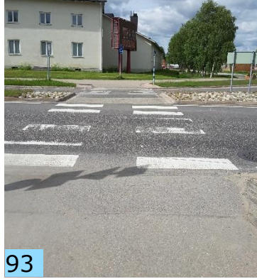
Suojatielle ei ole reunatukea Ivalontielle, merkinnät ovat kuluneet.
