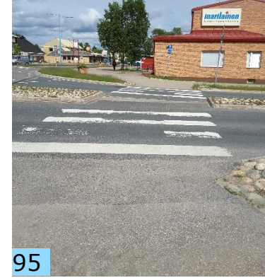
Suojatielle ei ole reunatukea Piiskuntielle, merkinnät ovat vinot.
