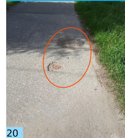
Kaivonkannet ovat kuopalla Koppelontien varrella.
