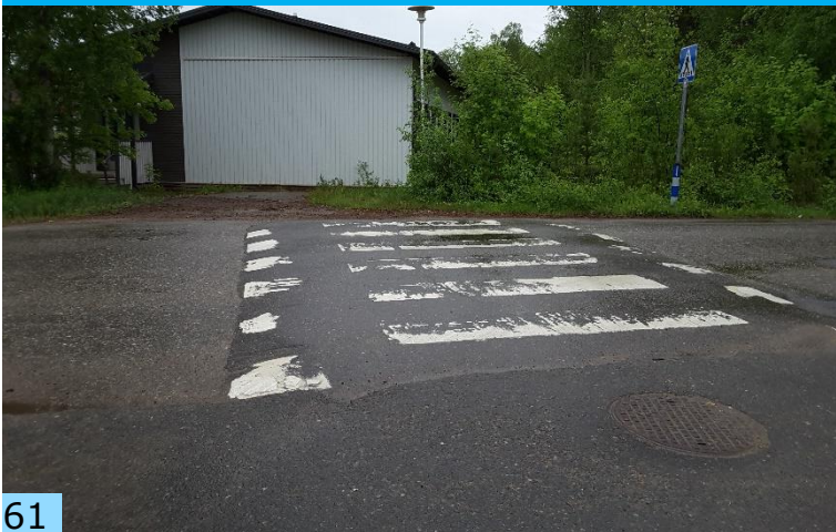
Suojatiellä ei ole reunatukea Ivalontien varrella, merkinnät ovat kuluneet.
