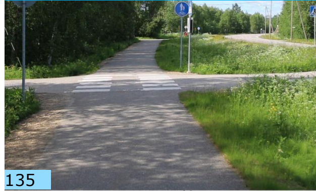
Suojatien reunatuki puuttuu Patunankiepillä.
