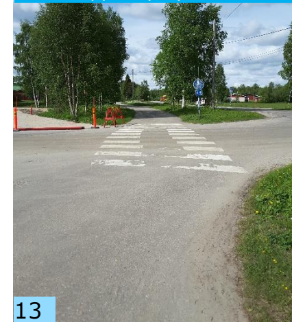
Suojatiellä ei reunatukea, ei pääty jalankulku- ja pyöräilyväylälle.
