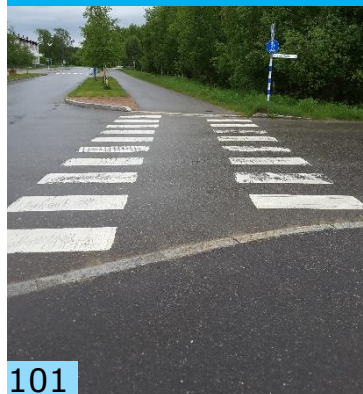
Reunatuki on liian korkea Hevosmiehentiellä, merkinnät ovat kuluneet.
