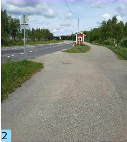
Bussipysäkille pääsee hyvin. Sitä ei ole korotettu. Katokseen 80 mm korkea kynnyks.
