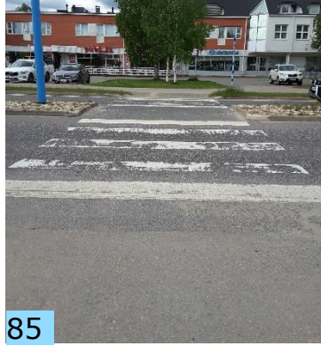
Suojatielle ei ole reunatukea Ivalontielle, merkinnät ovat kuluneet.
