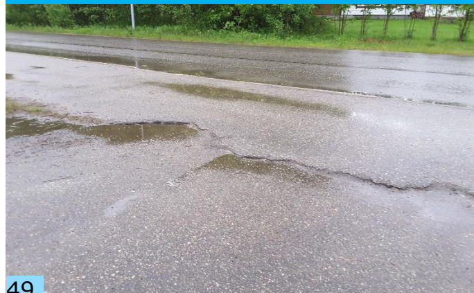
Routavaurioita väylällä Kaamostien varrella. Sivukaltevuus paikoin yli 3 %.
