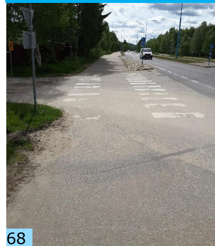
Suojatiellä ei ole reunatukea Sudentien varrella, merkinnät ovat kuluneet.
