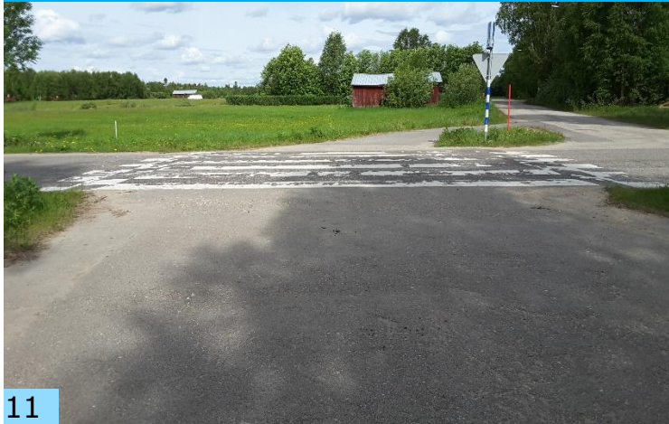
Suojatiellä ei ole reunatukea Koppelonttiellä, suojatiemerkinnyt ovat kuluneet.
