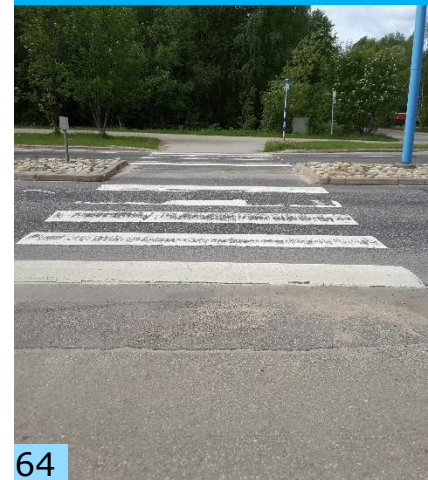
Ivalontien varrella suojatiellä ei ole reunatukea, merkinnät ovat kuluneet.
