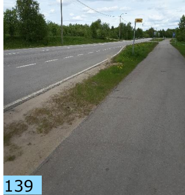
Ei kunnollista jalankulun väylää pysäkillä Petsamontien varrella.
