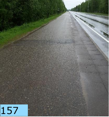
Ivalontien varrella väylällä paikoin liikaa sivukaltevuutta (3,4 %)
