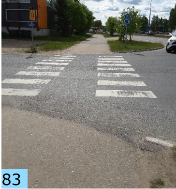
Suojatielle ei ole reunatukea Peuratiellä, merkinnät ovat kuluneet.
