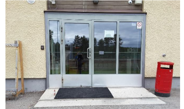
Pääoven edessä korkea kynnyks ja matto, ylempi tasanne liian kapea.
