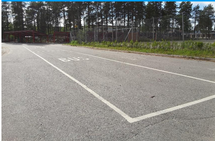
Bussipysäkkiä ei ole korotettu
