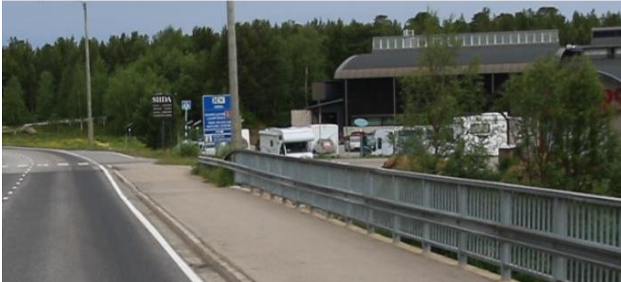
Kuva 23. Huutokalliontien liittymä valtatie sillalta katsottuna.
