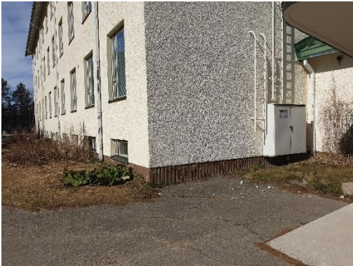
Kuva 3. Pääsisäänkäynnin edestä, jossa sadevedet jäävät syvennykseen. Kasvillisuus kasvaa seinustalla kiinni ympäri rakennusta.
