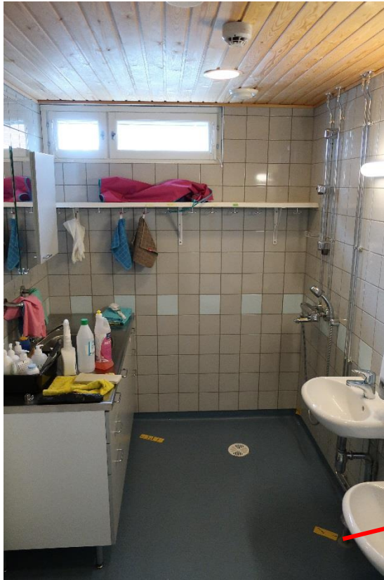
Kuvat 38 ja 39, päiväkotien märkätiloissa vuotoja havaittiin lattiamaton ylösnostoissa ulkoseinustoilla, mutta poikkeuksellisesti tässä tilassa (B140) sokkeliin syötetty kaasu kulkeutui käsienvesualtaan putkiläpiviennille saakka
