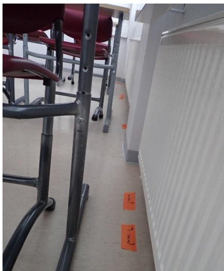
Kuvat 5 ja 6, tila 154, vuotojen sijainteja kuvattu teipein
