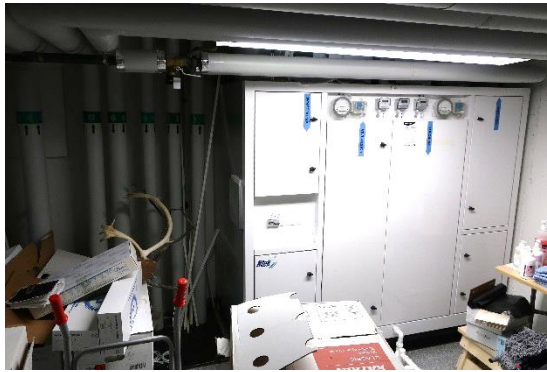
Kuvat 28 ja 29, tilassa B123 (LVI) vasemmassa nurkassa useita putkiläpivientejä, joilta havaittiin tulevan laaja-alaisesti kohtalaista vuotoa, mistä johtuen koko tilassa oli runsaasti kaasua mittausketkellä. Putkiläpiviennit ovat yhteydessä kellaritiloihin
