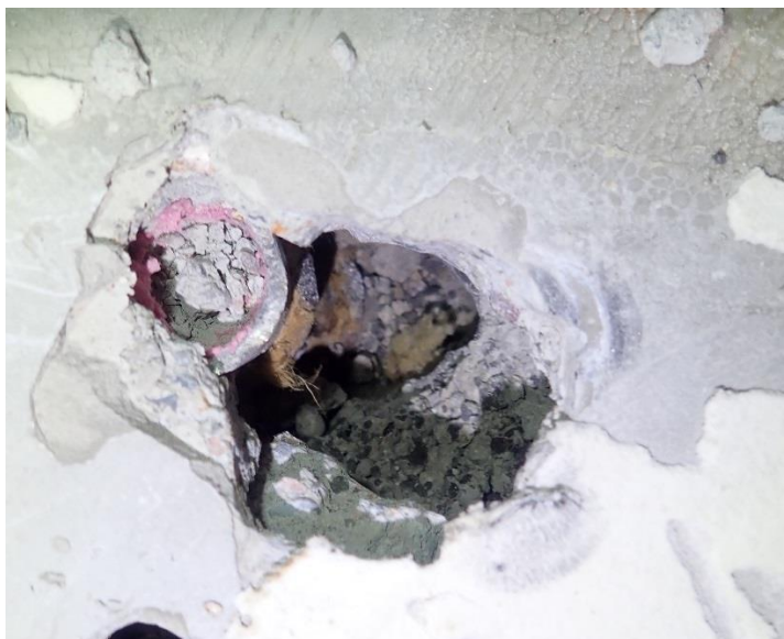
Kuva 3, vanha patteriputki villaeristeineen
