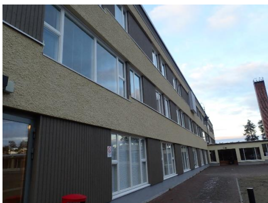
Kuva 21, monitoimitalon julkisivua, sisäpihan puoli
