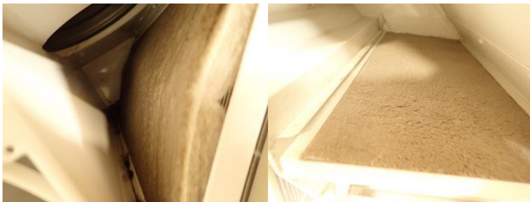
Kuva 120. Tulo- ja poisto karkeasuodattimet tukossa
