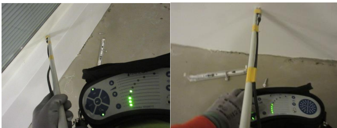
Kuvat 107 ja 108, ruokala. Kohtalaista vuotoa ikkunan karmeilta sekä patterin kannakkeiden kohdilta.
