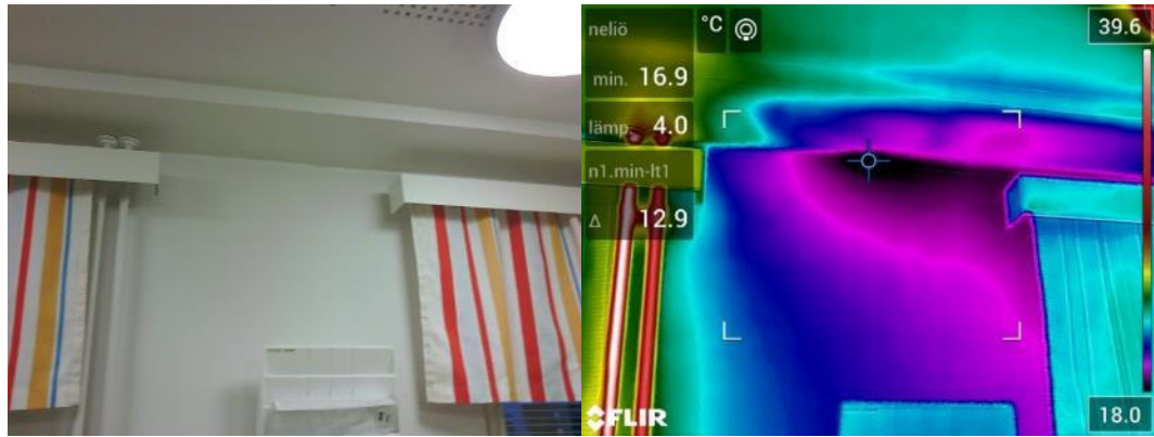
Kuva 67. B111 ulkoseinän ja välipohjan liitos viilentymää. Ulkolämpötila +2,2
