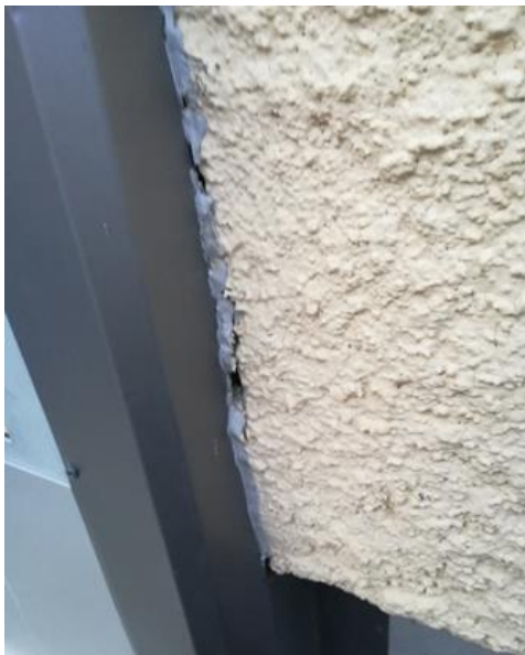
Kuva 33, oven saumauksissa epätiiveyksiä
