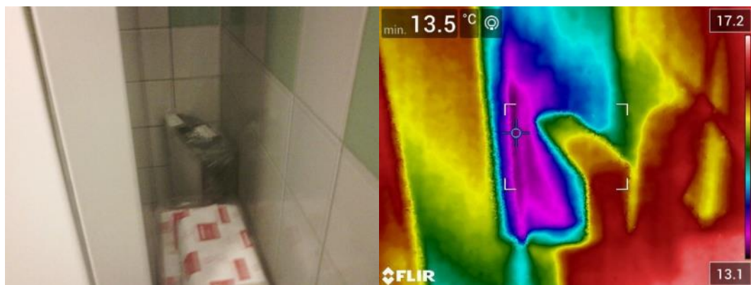
Kuva 86. B303 IV-koneen takana ulkoseinässä viilentymää. Ulkolämpötila -10,5
