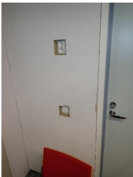
Kuva 117. Äänieriste levytyksessä avonaisia villapintoja
