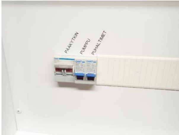
Kuva 114. IV-koneen virtakytkimet päällä
