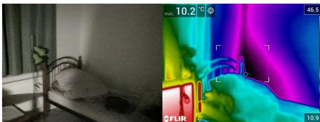
Kuva 83. B329 iv-konehuonetta vasten olevassa ulkoseinässä nurkassa viilentymää. Ulkolämpötila -10,5
