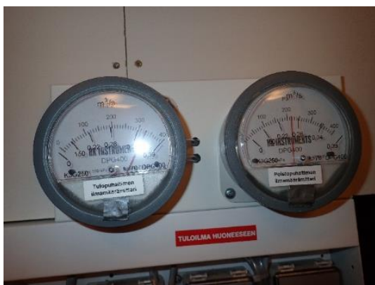
Kuva 122. Tilan B303 IV-koneen ilmamäärät liian suuret
