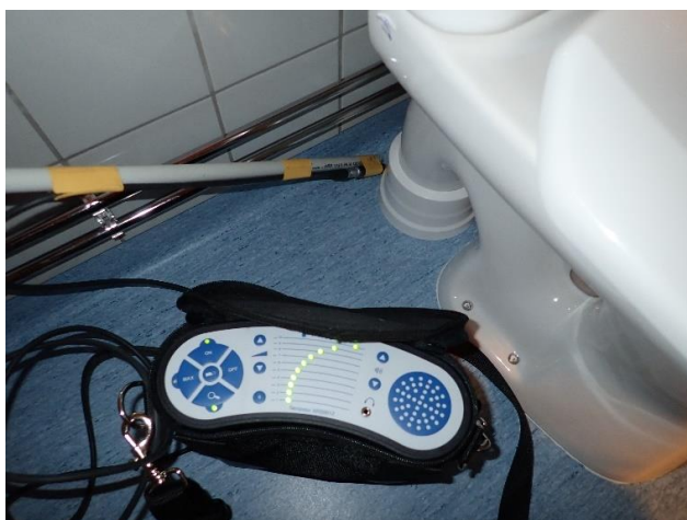
Kuva 132. Tila B208, vuotoa wc-istuimelta
