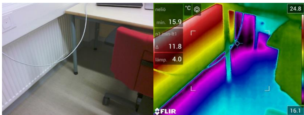
Kuva 54. A146 seinän ja lattian liitoksessa viilentymää. Ulkolämpötila +2,2
