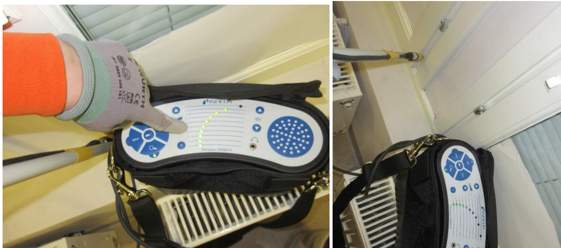
Kuvat 104 ja 105, tila B137 (päiväkoti Tammukat). Runsasta sekä kohtalaista vuotoa ikkunan karmeilta.
