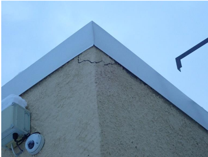
Kuva 17, koulurakennus, lasikäytävän viereisten luokkien monitoimitalon pääty, joen puolella.
