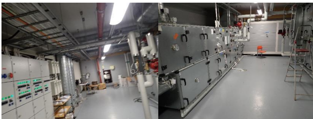
Kuvat 109 ja 110 .Yleiskuvia IV-konehuone
