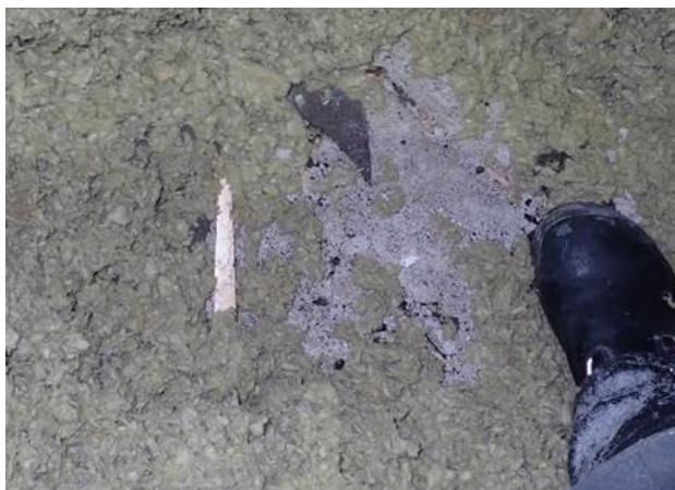
Kuva 4. Koulurakennuksen katto, yhdyskäytävän puoleinen pääty. Eristeen paksuus noin 300...350 mm. Eristeen seassa puujätettä.
