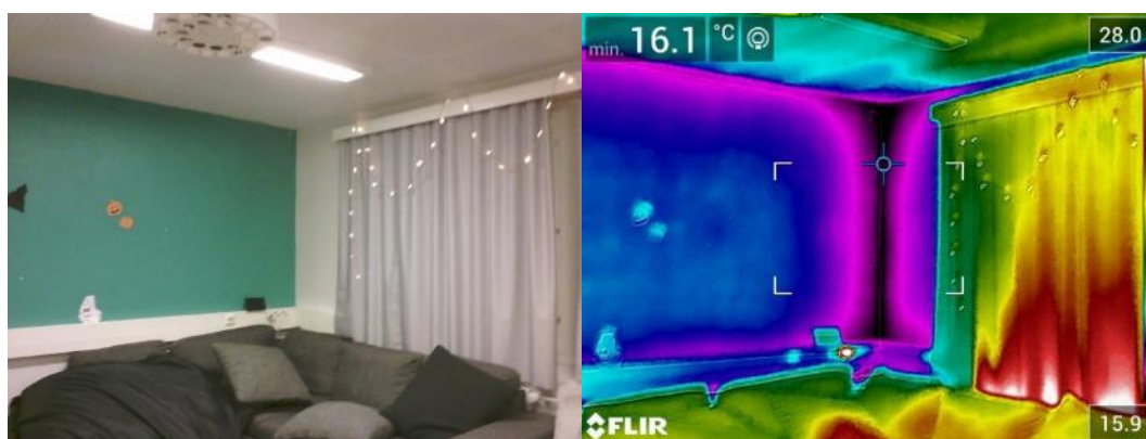
Kuva 81. B359 ulkoseinän ja yläpohjan liitoksessa viilentymää. Ulkolämpötila -10,5
