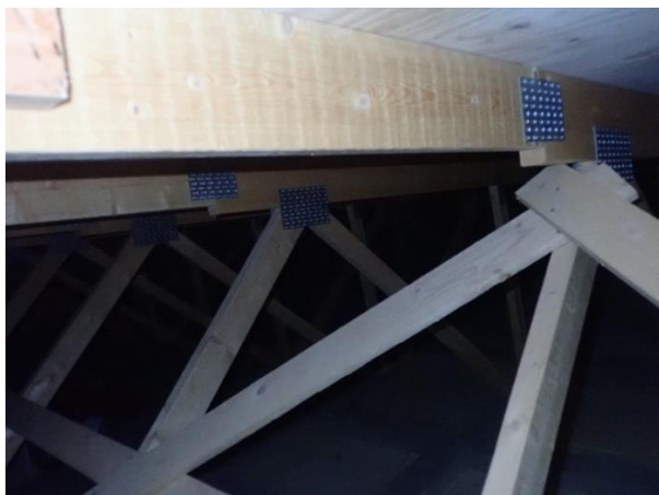
Kuva 3. IV-konehuoneen kattoa, luukulta tarkasteltuna ei havaittu viitteitä vaurioista
