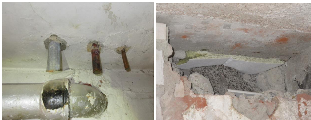
Kuvat 47 ja 48, kellarin katossa/seinien yläosissa erilaisia katkaistuja, villaeristeisiä putkia. Yhdessä kohtaa todettiin myös levyvillaa.
