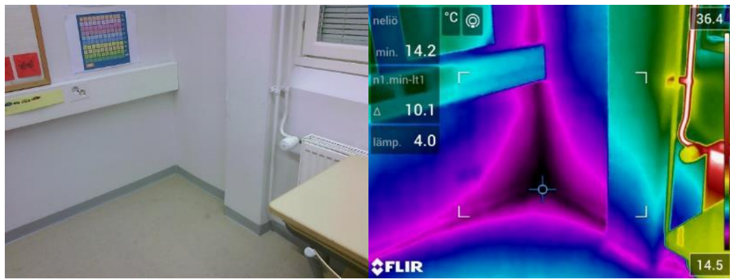
Kuva 53. A153 Ulkoseinän nurkassa viilentymää. Ulkolämpötila +2,2
