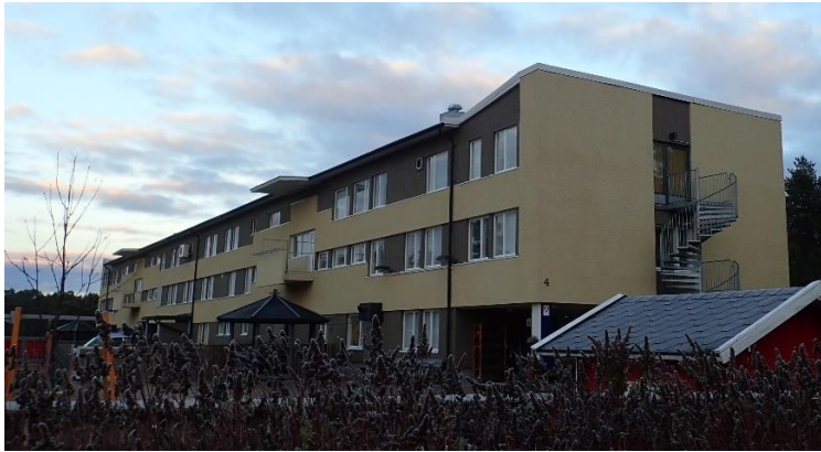
Kuva 22, monitoimitalo, päiväkotien ulkoilupihojen puoli
