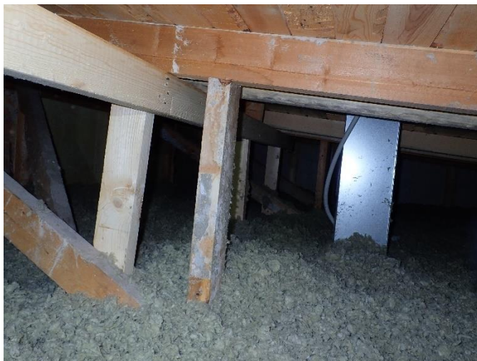
Kuva 2. Yleiskuva yhdyskäytävän katolta. Ei havaittu vaurioita, puupiikkimittarilla mitaten arvot välillä 10,2...11,2 %RH. Luukulta mitattuna tilan korkeus noin 780 mm holvin pinnasta.
