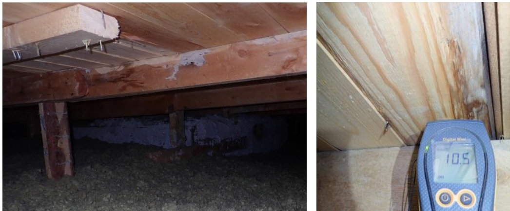
Kuvat 10 ja 11. Monitoimitalon yläpohja, tässä päädyssä puhallusvillaa noin 400 mm. Kuvassa 10 vanha palopermanto. Yhdellä tuuletusputkella havaittavissa vanhoja vuotojälkiä, puupiikkimittarilla ei todettu kohonneita arvoja.
