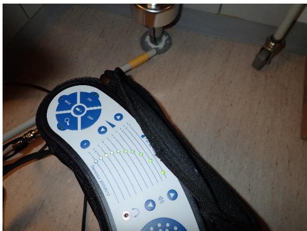
Kuva 130. Tila B209, vuotoa viemäriputken tulppaukselta
