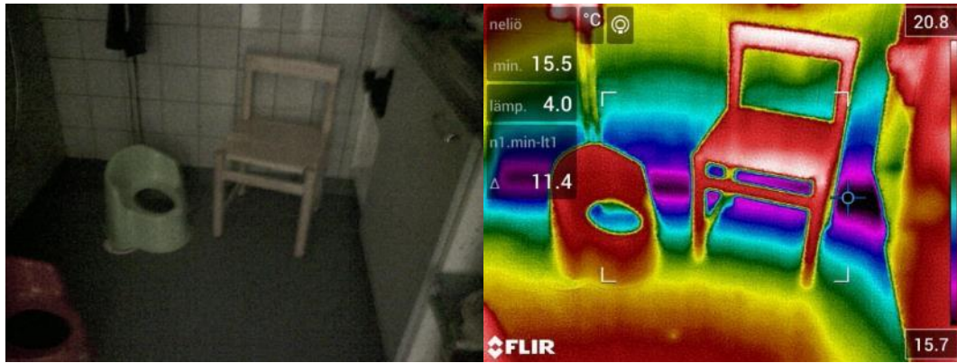
Kuva 64. B103 seinän ja lattian liitoksessa viilentymää. Ulkolämpötila +2,2
