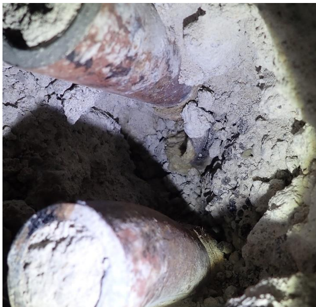
Kuva 128. Eriste ja tervapaperi nähtävillä putken juurella
