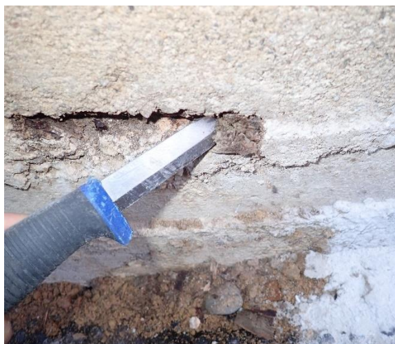
Kuvassa puuta sokkelin pinnalla
