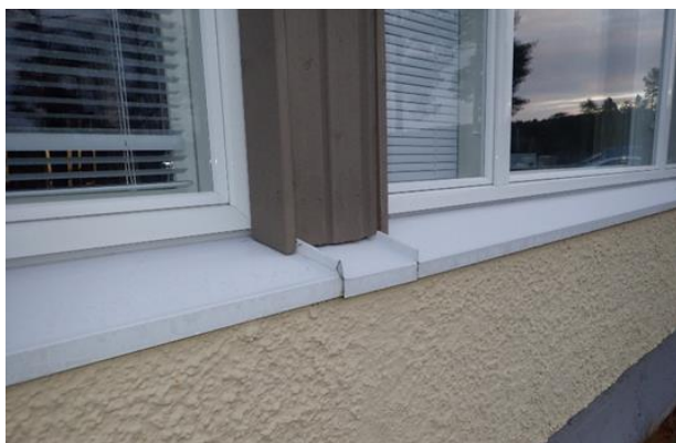
Kuva 30, Ikkunat ja ikkunapellitykset pääosin hyväkuntoiset
