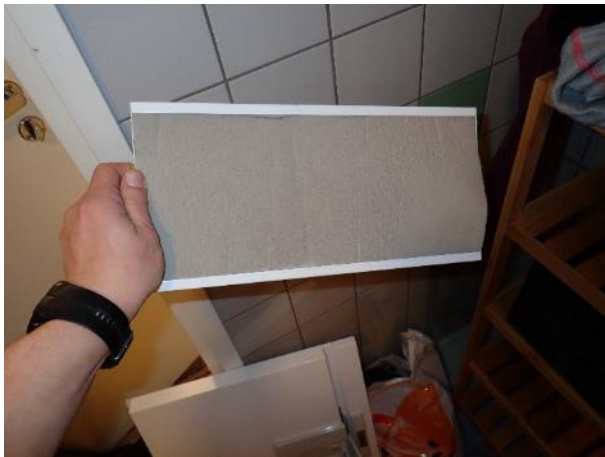
Kuva 124. Suodatin likainen
