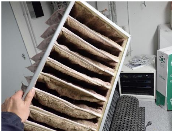
Kuva 115. Tuloilmasuodatin tukossa
