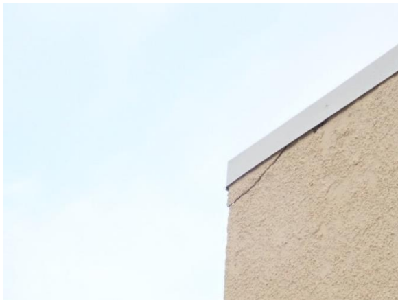
Kuva 23, Halkeama monitoimitalon joen puoleisessa päädyssä
