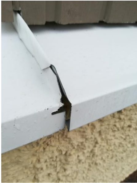
Kuvat 31 ja 32, ikkunoiden pellityksissä epätiiveyksiä
