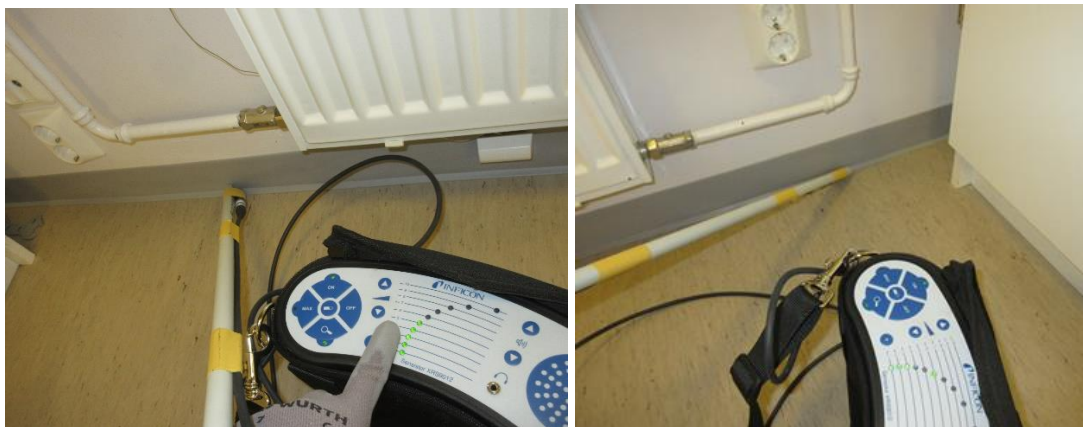
Kuvat 98 ja 99, joen puoleinen pääty, tila B137 (päiväkoti Urbi). Runsasta ja kohtalaista vuotoa lattialistan reunalta.
