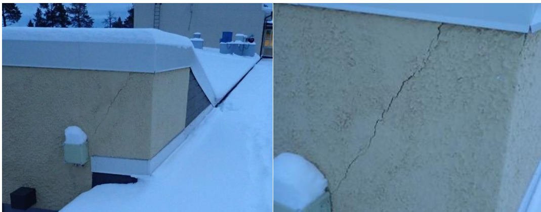
Kuvat 15 ja 16, koulurakennus, lasikäytävän viereisten luokkien monitoimitalon pääty, sisäpihan puolella
