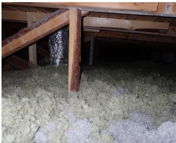
Kuva 9, monitoimitalo yläpohja, joen puoleinen pääty. Eristeenä mineraalivillaa sekä paikoin myös selluvillaa, yhteensä noin 200 mm.
