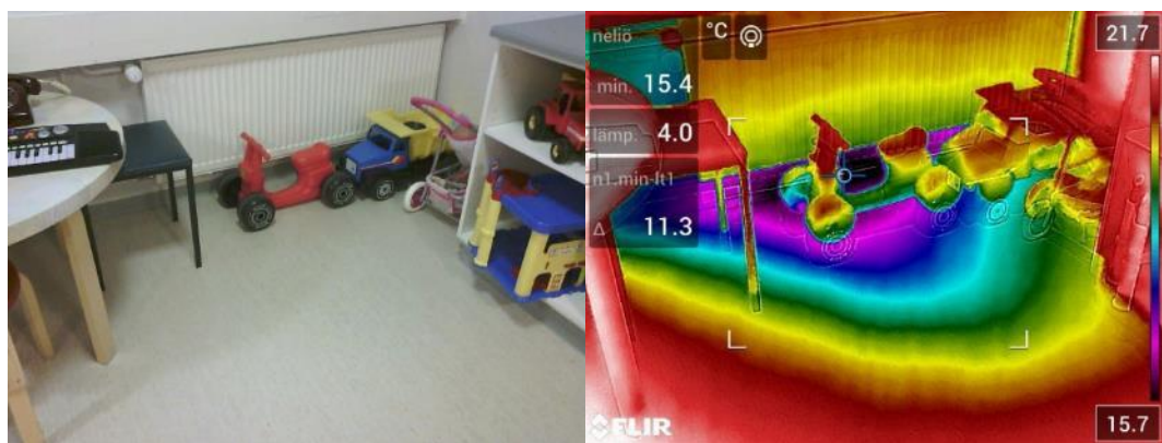
Kuva 69. B202 välipohjan ja ulkoseinän liitoksessa viilentymää. Ulkolämpötila +2,2
