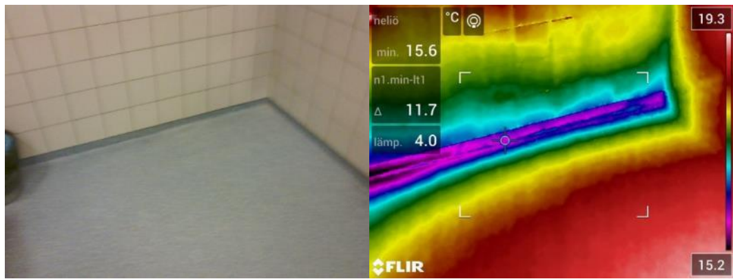
Kuva 73. B141 lattian ja seinän liitoksessa viilentymää. Ulkolämpötila +2,2
