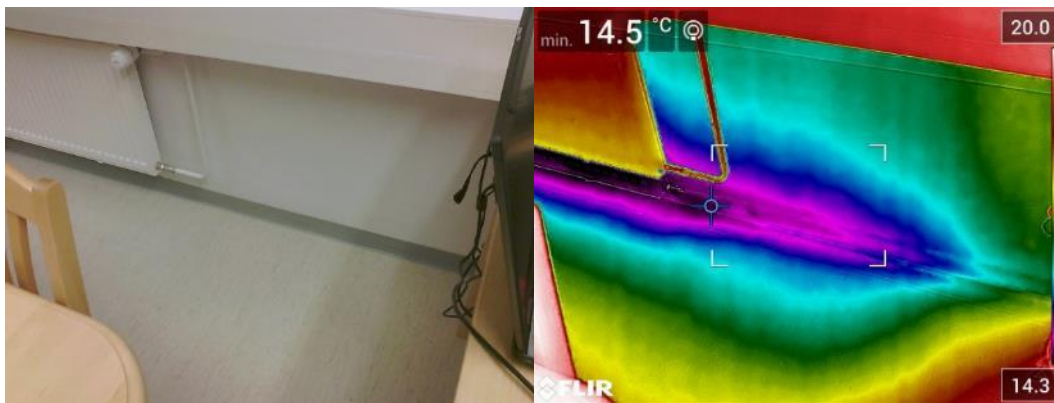
Kuva 88. B201 ulkoseinän ja välipohjan liitoksessa viilentymää. Ulkolämpötila -10,5
