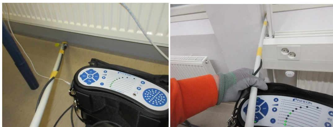
Kuvat 90 ja 91, tila 153, runsasta vuotoa lattialistan reunoilta, lievää ikkunoiden karmeilta
