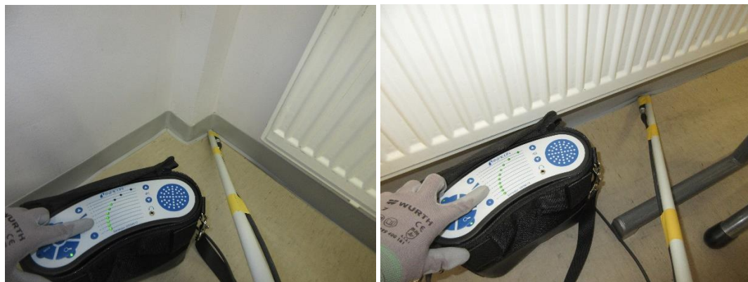
Kuvat 92 ja 93, tila 154, ulkoseinälinjalla kattavasti runsasta vuotoa lattialistan reunoilta
