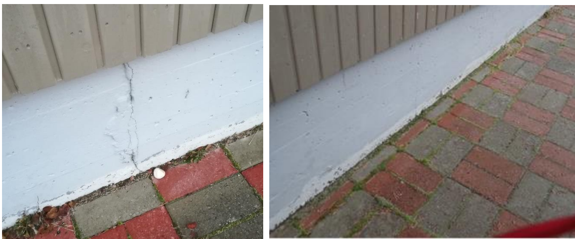
Kuvat 26 ja 27, monitoimitalo, sokkelipinnoilla pystyhalkeilua. Seinustan rajalla vähäistä sammalkasvustoa, patolevyä ei havaittavissa.
