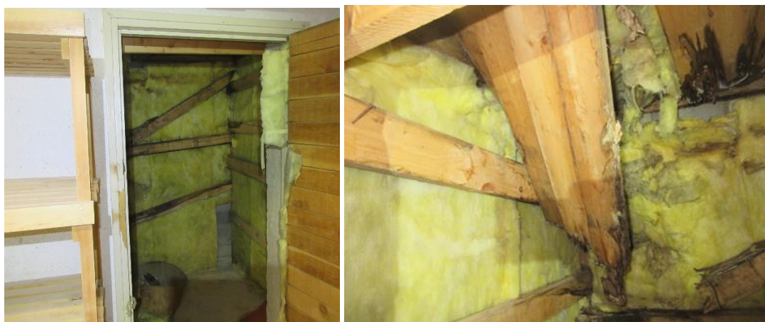
Kuvat 49 ja 50, vanha halkokuilu, selkeät laho- ja mikrobivauriot.
