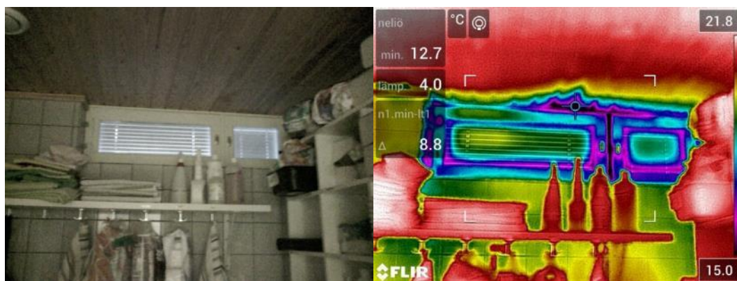
Kuva 65. B103 Ikkunassa ilmavuotoa. Ulkolämpötila +2,2
