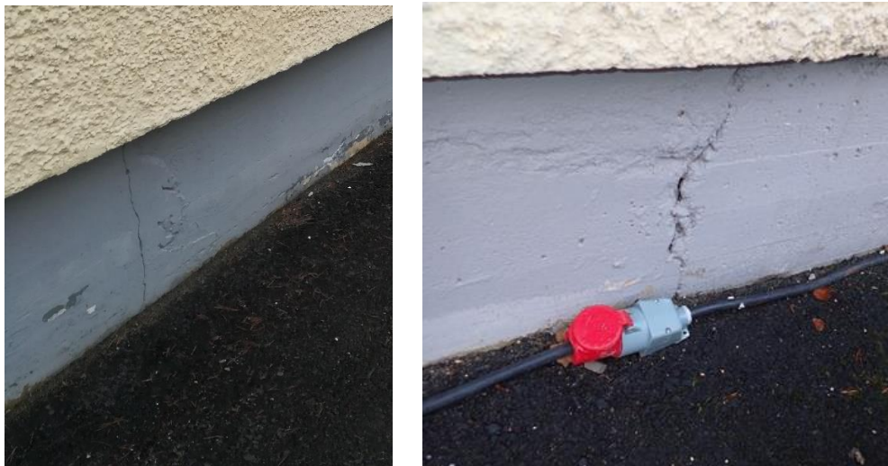
Kuvat 24 ja 25, koulurakennus, sokkelipinnoilla pystyhalkeilua
