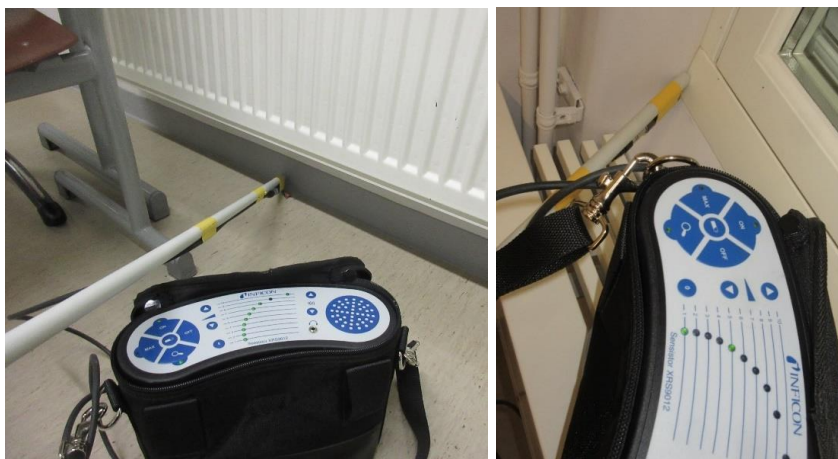
Kuvat 95 ja 96, tila A117, ulkoseinälinjalla lattialistan reunalta kohtalaista, ikkunoiden karmeilta lievää vuotoa. Alipaine mittaushetkellä n. -3,5 Pascalia ulkoilmaan nähden.
