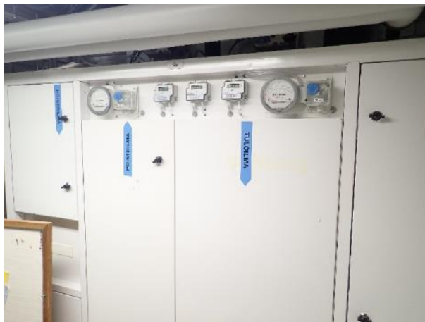
Kuva 113. Mittarien mukaan IV-kone ei ole toiminnassa
