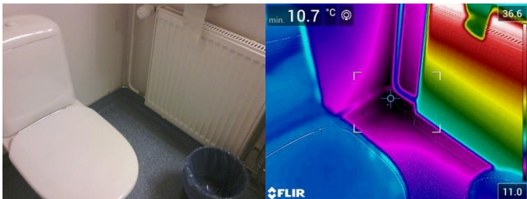
Kuva 61. A133 ulkoseinän nurkassa viilentymää. Ulkolämpötila -10,5
