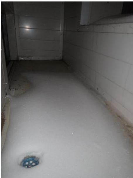
Kuva 119. Tuloilmakammiossa runsaasti lunta
