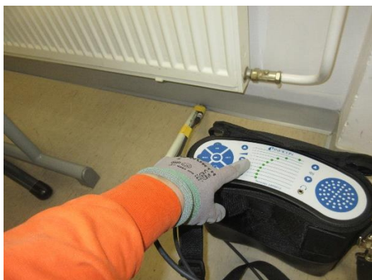
Kuva 94, tila 154, ulkoseinälinjalla kattavasti runsasta vuotoa lattialistan reunoilta
