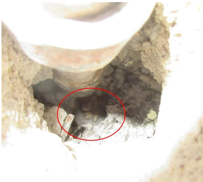
Kuva 126. Eristeen sijainti kuvassa ympyröitynä
