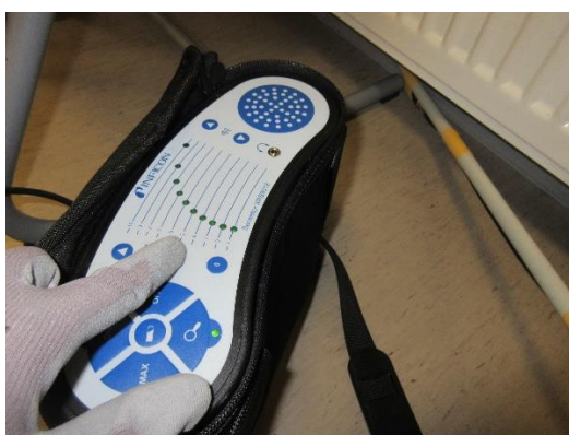
Kuvat 102 ja 103, tila B106 (päiväkoti Tammukat). Kattavasti runsasta sekä kohtalaista vuotoa lattialistan reunoilta.
