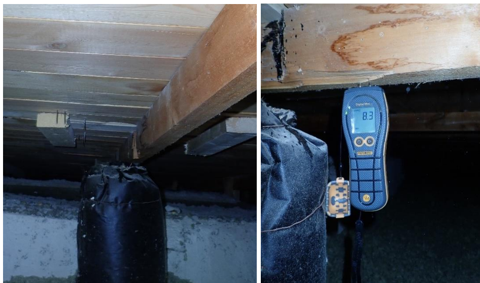
Kuvat 7 ja 8. Koulurakennuksen katto. Yläpohjan sisään jätetty vanha tuuletusputki, jonka ympäristössä vanhoja kosteusvauriojälkiä. Mikäli tuuletusputkea ei ole tulpattu, aiheutuu riski yläpohjarakenteen vaurioitumiseen, lämpimän ilman kohdatessa kylmä aluslaudoitus. Puupiikkimittarilla mitattaessa ei todettu kohonneita kosteuspitoisuuksia.
