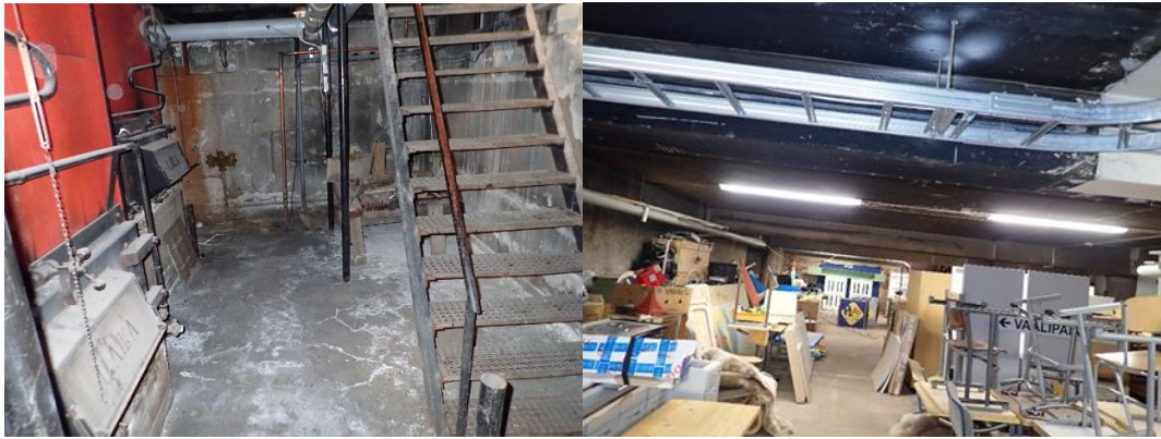
Kuvassa 41, yleiskuvaa alimmasta kellaritasosta, kuvassa 42 ylempältä tasolta
