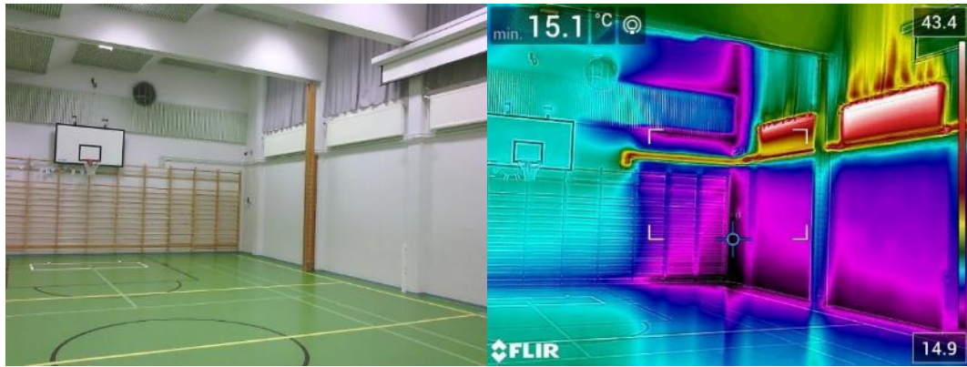
Kuva 59. Liikuntasali, 1-kerroksisen rakennuksen sivu. Kuvasta havaittavissa kohta, josta 1-kerroksinen osio alkaa. Ulkolämpötila -10,5
