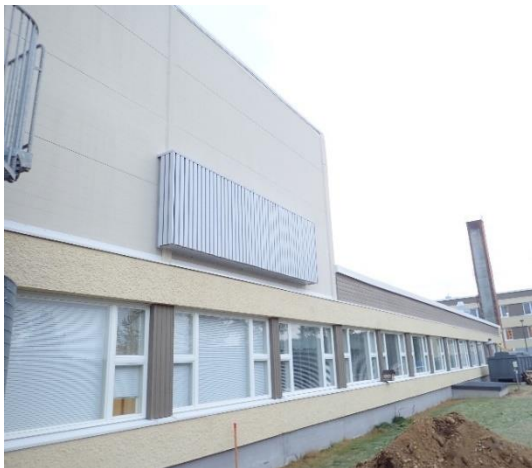
Kuva 13, koulurakennus, joen puoleinen sivu.
