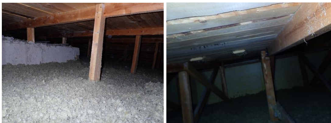
Kuvat 5 ja 6. Koulurakennuksen katto, ei viitteitä kosteusrasituksesta. Alueilla, joissa julkisivuna tiiliverhous, ei ole lisäeristystä, rapatuilla alueilla on. Kuvassa 5 nähtävillä myös vanha palopermato.
