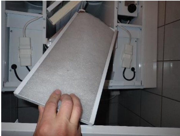
Kuva 123. Tilan B308 suodattimet puhtaat
