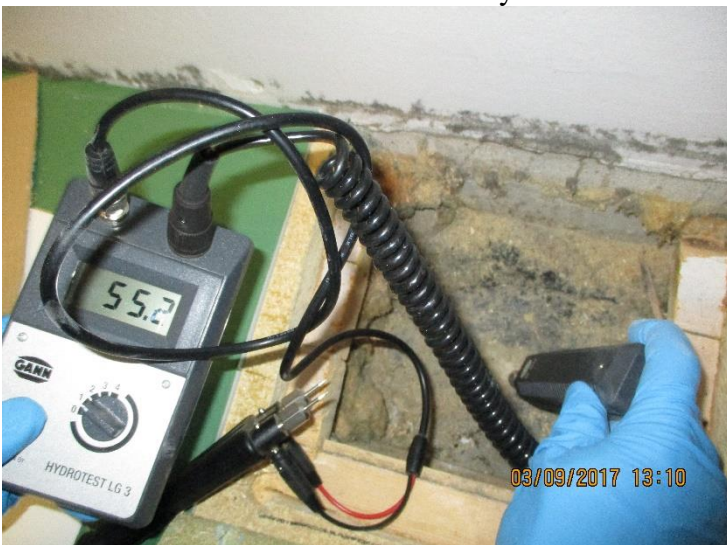
Kuva 27. RA3 Betonin kosteus oli tavanomainen pintakosteusilmaisimella mitattuna.
