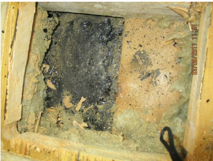
Kuva17. RA2 betonin pinnassa bitumisively kosteussulkuna. Materiaalinäyte otettiin bitumointia vasten olevasta eristeestä (mikrobi) ja bitumoinnista (asbesti ja PAH).
