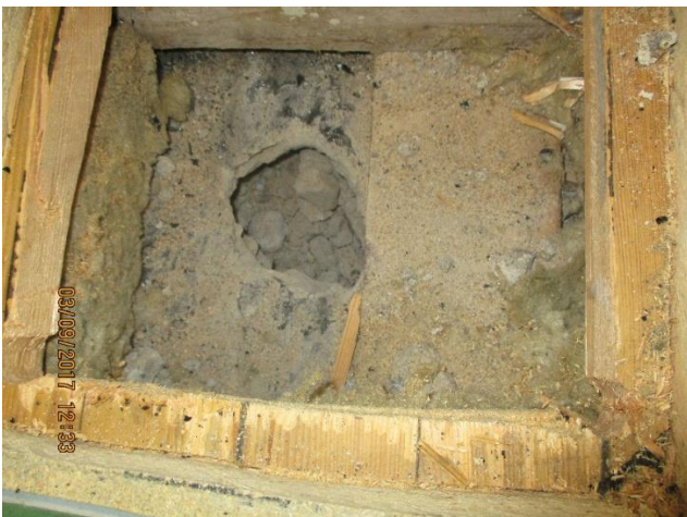
Kuva21. RA2 Laatan alta otettiin maa-ainesta maanäytettä varten
