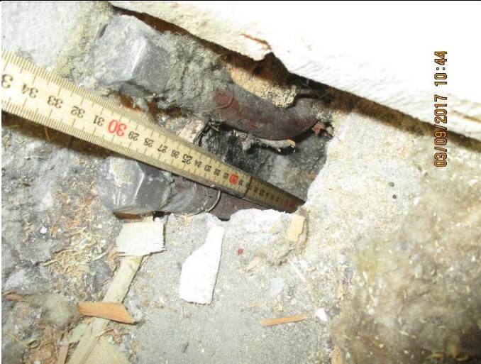
Kuva11. RA1 Ilmavuoto johtui lattian alta löytyneestä putkikanaalista, joka on jätetty tiivistämättä kun päällyspuolisia rakenteita on suljettu.
