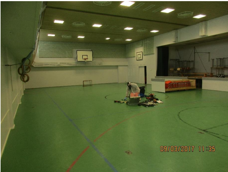
Kuva15. RA2 rakenneavaus liikuntasalin keskeltä
