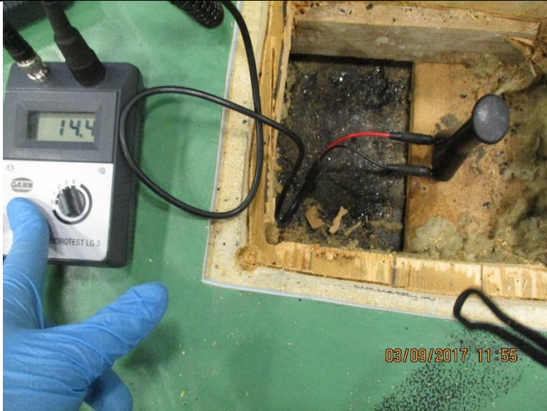
Kuva19. RA2 Betonilaattaa vasten olevan laudan kosteusarvot olivat koholla huomioon ottaen rakenteen ikä.
