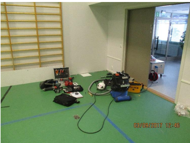
Kuva 24. RA3 rakenneavaus kohta
