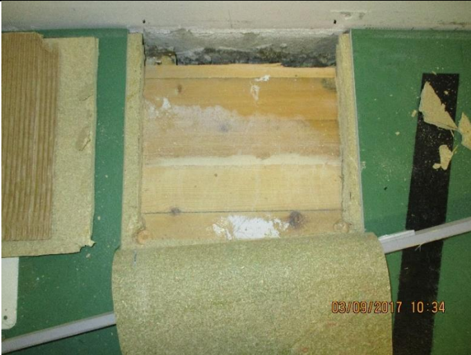
kuva8. RA1 Aaltopahvin alapuoli. Lattian ja seinän liittymäkohdassa noin 5cm rako, josta rakenteen alapuolella olevat epäpuhtaudet ovat päässeet tulemaan sisäilmaan
