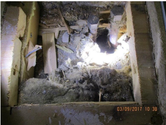
Kuva9. RA1 Puulattian alapuolinen rakenne. Materiaalinäyte otettu betonia vasten olevasta villasta.
