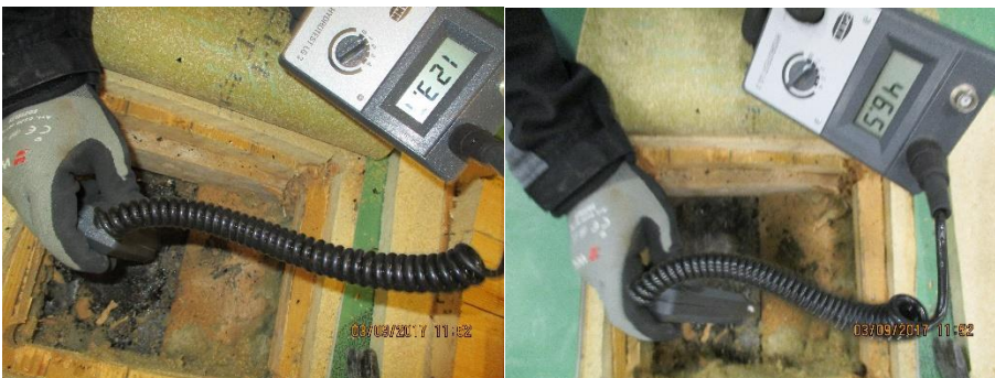
Kuva18. RA2 Pintakosteusilmaisimen luvut heittelivät riippuen siitä mistä materiaalista mitattiin. Paljalta betonilta otettu mittaus on normaali.
