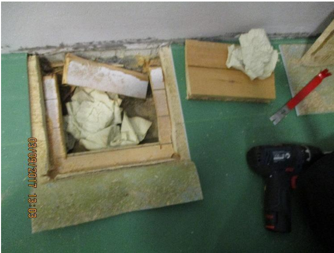
Kuva 25. Samalta kohtaa oli joskus tehty pieni rakenneavaus, paikkaukseen oli käytetty käsipaperia joka ei kuulu lattia rakenteeseen.
