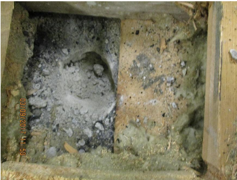
Kuva20. RA2 Betonilaattaan tehtiin reikä rakenteen selvittämiseksi. Betonin kosteusprosetti 4,74%.
