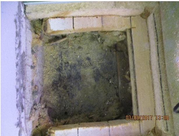
Kuva 26. RA3 Seinän ja puulattian rajassa oli noin 5cm rako, josta epäpuhtaudet pääsevät nousemaan liikuntasaliin. Materiaalinäyte otettiin bitumia vasten olevasta eristeestä.
