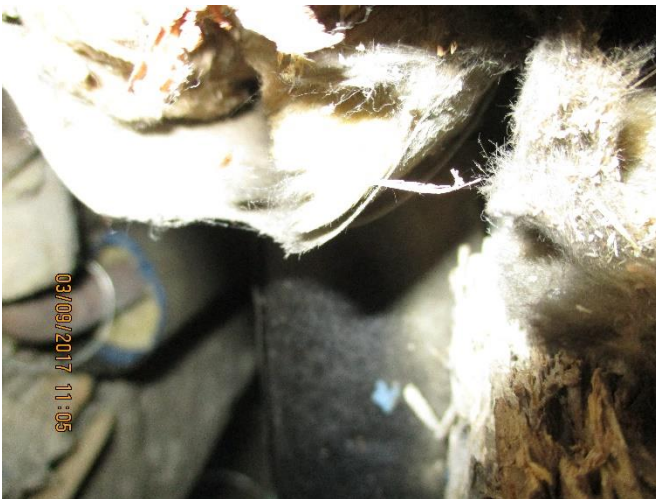
Kuva12. RA1 putkieristeistä otettiin materiaali näyte, Tojax-eristeestä otettiin materiaalinäyte.
