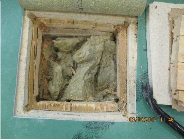
Kuva16. RA2 Villoitus oli hajanaista ja näytti kuin olisi käytetty ”jämäpaloja” eristykseen
