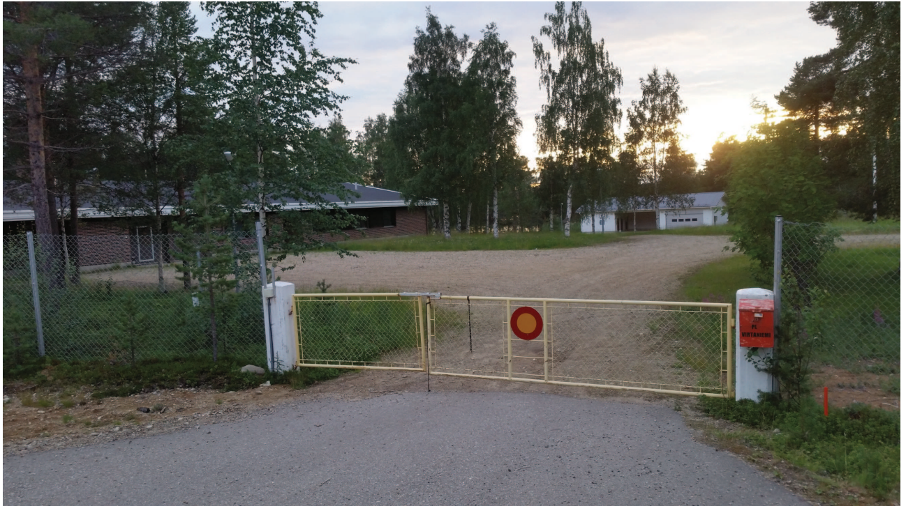
Kuva 1. Portti, vartiorakennus ja kalustohalli
