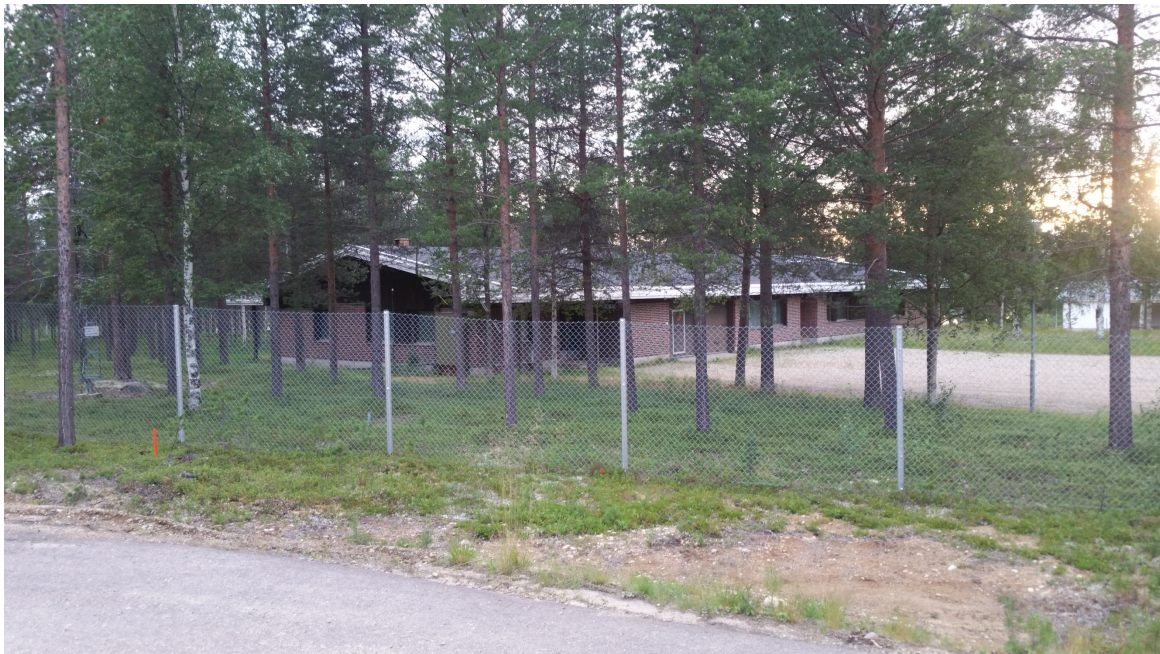
Kuva 1. Vartiorakennus Nellimintieltä kuvattuna
