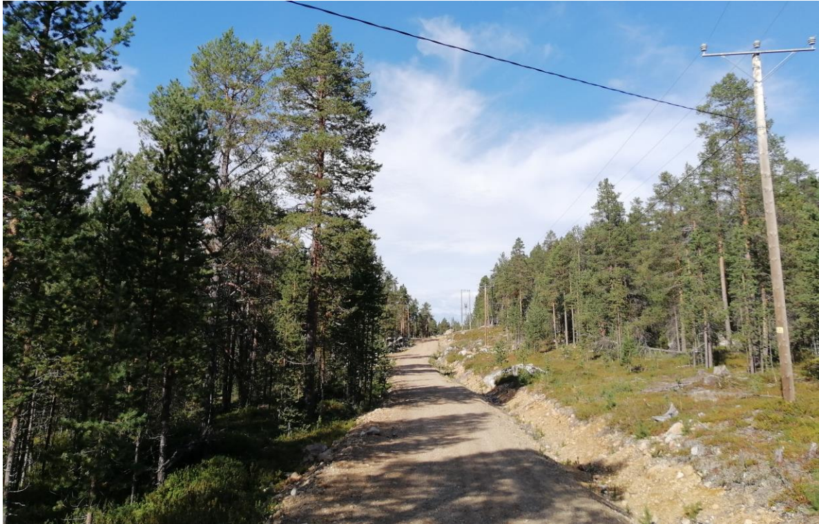
Kuva 11. Suunnittelualueelle tulee kunnostettu sorapäälysteinen yksityistie ja 20 kV ilmajohto.
