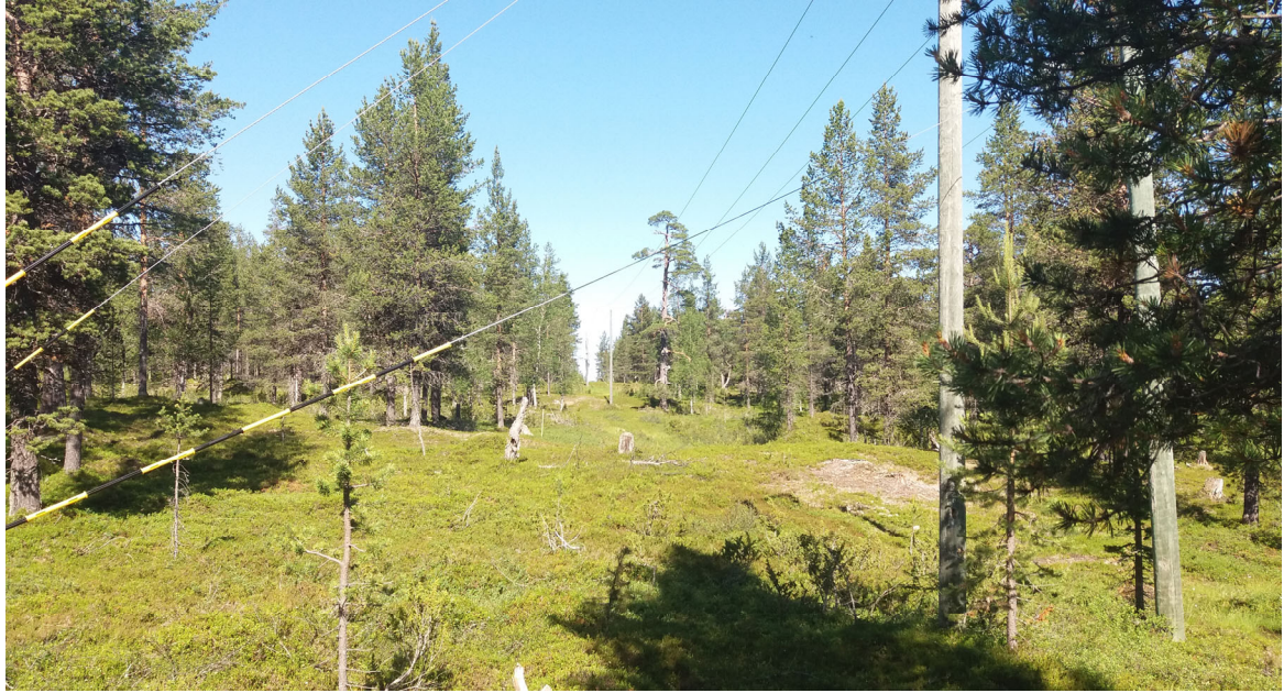
Suunnittelualueella kulkeva sähkölinja.
