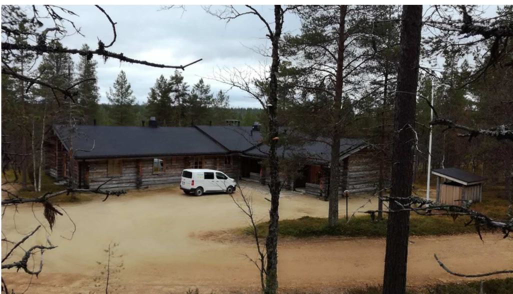
Alueen eteläosan rakennuskantaa.
