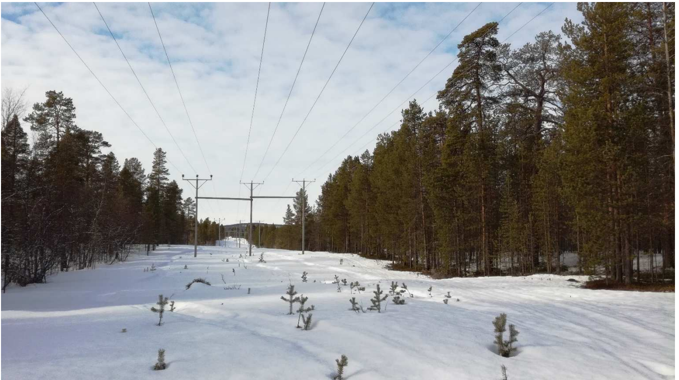
Alueen pohjoisosan sähkölinja.
