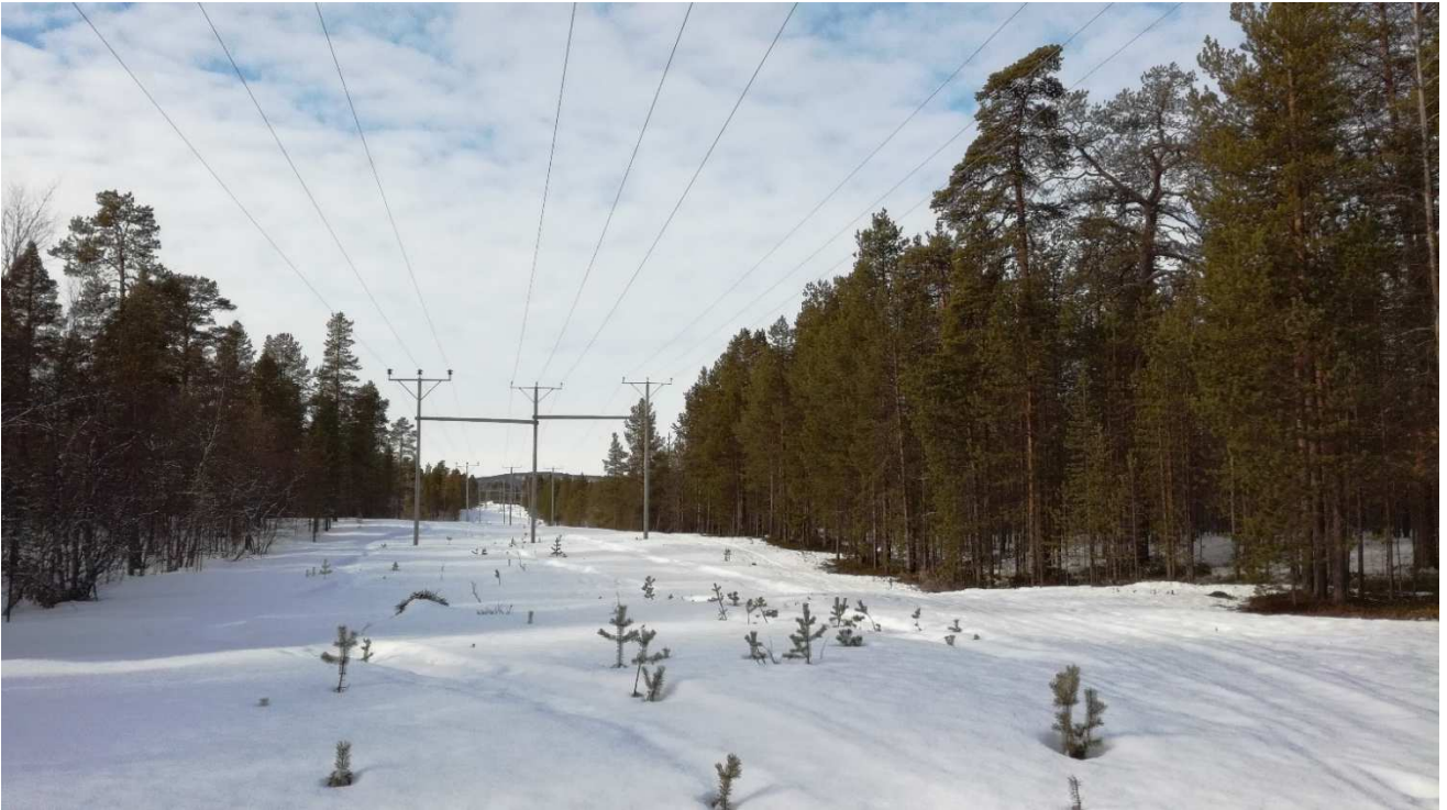
Alueen pohjoisosan sähkölinjat. Kaksi vasemman puolimmaista linjaa puretaan lähivuosina.
