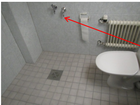
Kuvat 9 ja 10. Tilan 166 WC/kph:n seinässä olevan pesukoneen poistokulman kautta kulkeutuu huonetilaan viemärinhajua.
