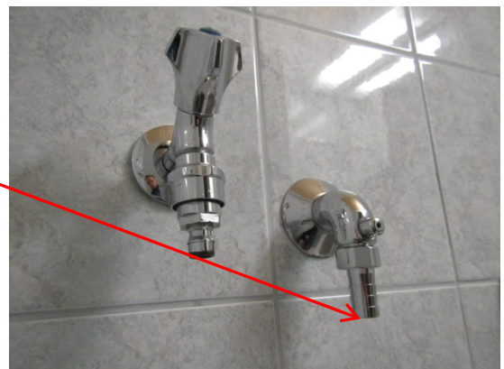
Kuvat 9 ja 10. Tilan 166 WC/kph:n seinässä olevan pesukoneen poistokulman kautta kulkeutuu huonetilaan viemärinhajua.
