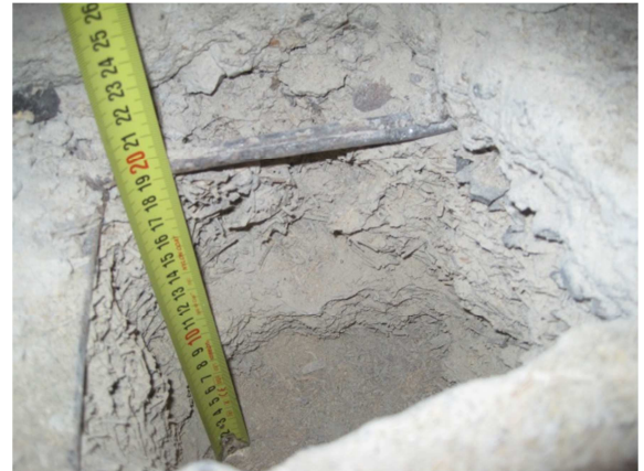
Kuva 44. RA32, tila 336, yläpohja, Toja-levyn alla on betonilaatta.
