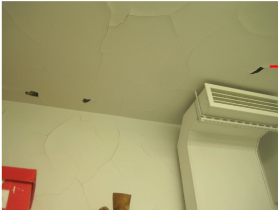
Kuvat 3-4. Päärakennuksen mankeli- ja silityshuoneen (008) seinissä ja katossa on maalin ja tasoitteen alla bitumikerros, jonka pinnalta tasoite lohkeilee irti.
