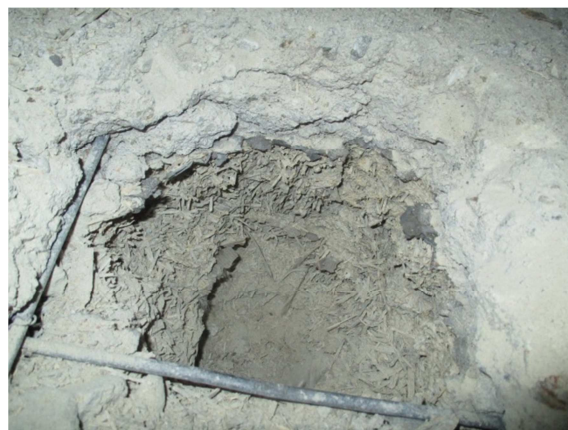
Kuva 26. RA20 (tila 405) raudoite ja Toja-levyeriste esillä
