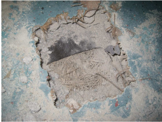
Kuva 40. RA31, tila 331, välipohja: linoleum, tervapaperi ja Tojalevy.
