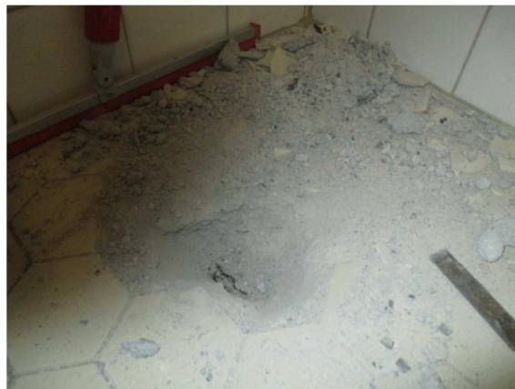
Kuva 12. RA5, pinta- ja pohjalaatan välissä on bitumisively.
