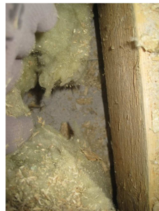
Kuva 18. RA8 lattiarakenne, koolaus ja pohjalaatta (tila 015)
