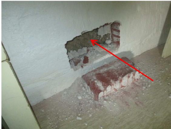
Kuva 6. RA1, Kuorimuurauksen takana on mineraalivillaeriste.
