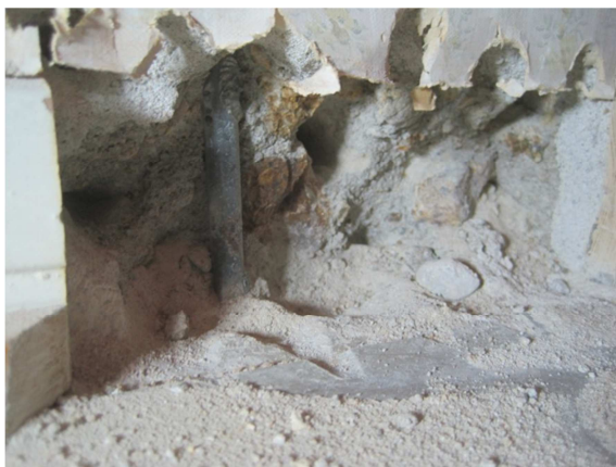
Kuva 36. RA27, tila 238, ulkoseinä.
