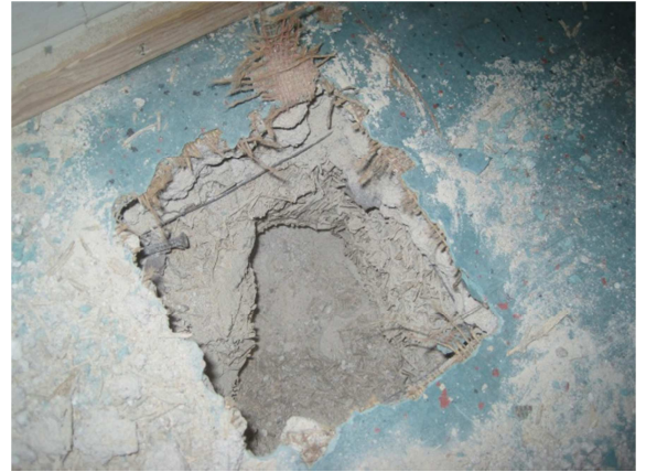
Kuva 41. RA31, tila 331, välipohja, Toja-levyn alla on betonilaatta.
