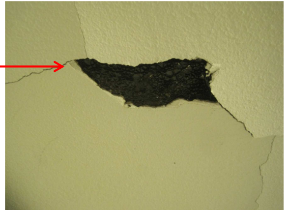
Kuvat 3-4. Päärakennuksen mankeli- ja silityshuoneen (008) seinissä ja katossa on maalin ja tasoitteen alla bitumikerros, jonka pinnalta tasoite lohkeilee irti.
