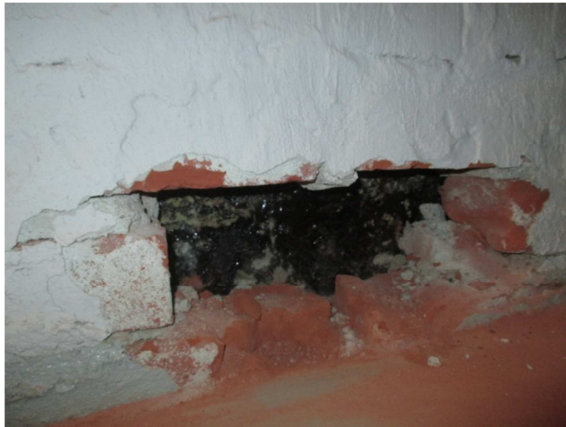
Kuva 9. RA3, kuorimuurauksen takana on ilmarako ja bitumisively.
