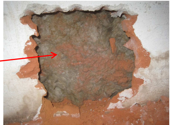
Kuva 31. RA22, Kuorimuurauksen takana on mineraalivillaeeriste.
