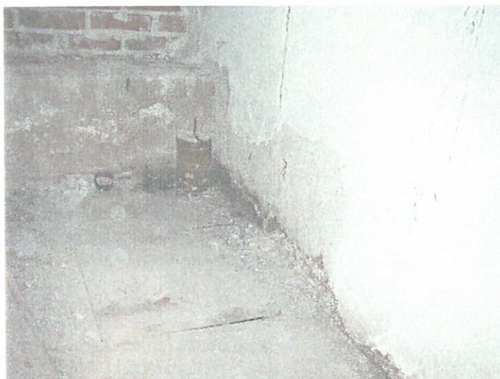
Sadevesikaivon vedenpinta käynyt rakennuksen historian aikana "ilmeisemmin" kanaalin seinien alaosien tasolla => vesi vaurioittanut kanaalin sisäseinien tojalevyeristeitä.
