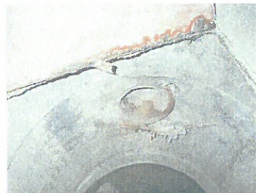
Sadevesijärjestelmän kaivon pohjalla lietettä.
