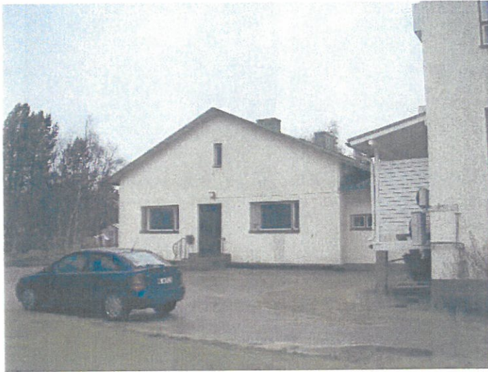
Huone 4 , kulku huoneistoon rakennuksen päädyn kautta.
