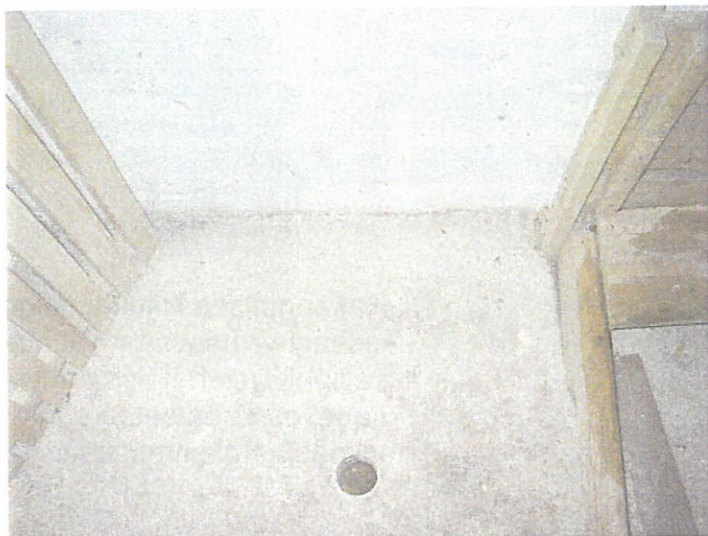
Tilojen alapohjaan porattu reikiä tutkimustyön aikana.
