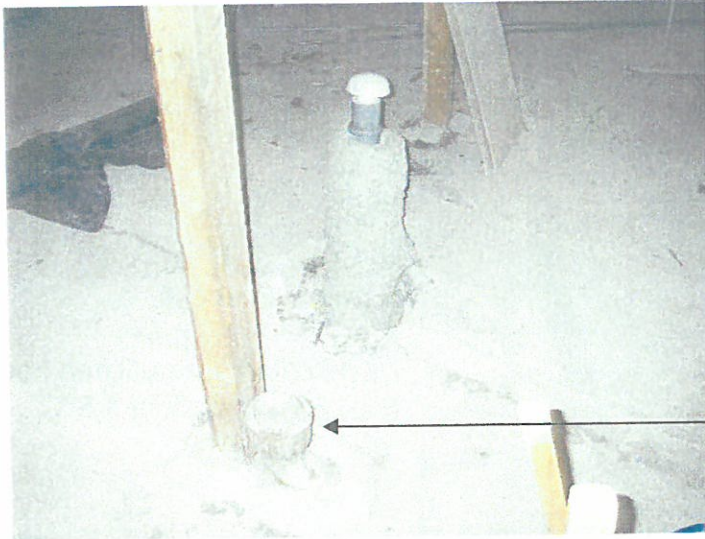
Viemärin tuuletusputki päättyy ullakkotilaan.
