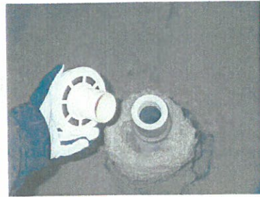
Viemärin tuuletusputki päättyy ullakkotilaan.
