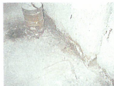
Sadevesikaivon vedenpinta käynyt rakennuksen historian aikana "ilmeisemmin" kanaalin seinien alaosien tasolla => vesi vaurioittanut kanaalin sisäseinien tojalevyeristeitä.
