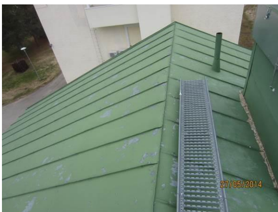
Kuva 31. Yleiskuva asuntolan katosta.
