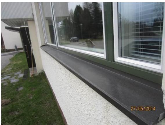
Kuva 23. Yleiskuva, ikkuna ulkoa.
