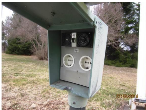
Kuva 64. Autolämmityspistorasia.
