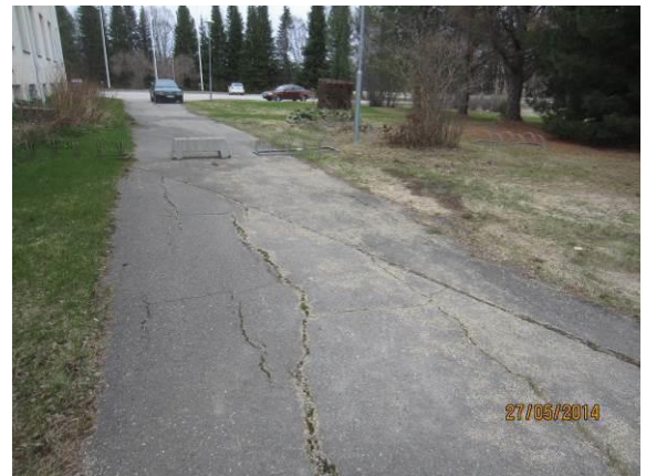
Kuva 3. Rakennuksen vierustan kulkutie.
