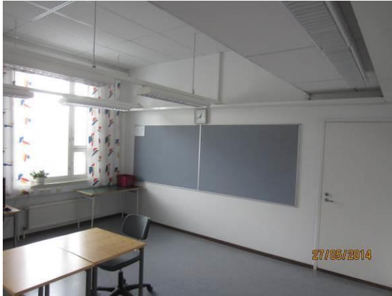
Kuva 43. Yleiskuva, remontoitu 2.krs luokkatila.
