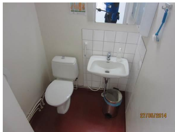
Kuva 42. 2.krs, alkuperäiskuntouen wc.
