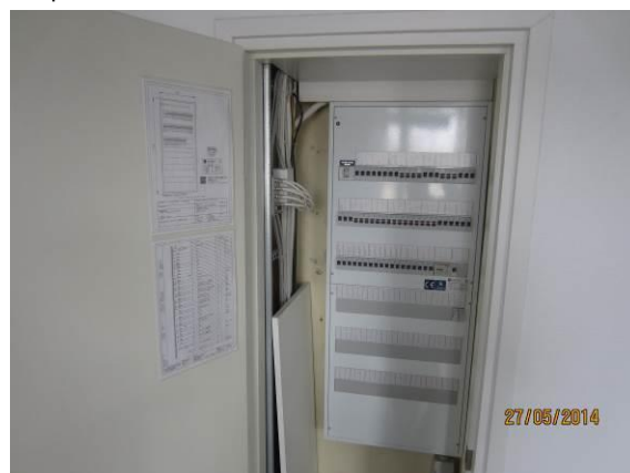
Kuva 59. 2.krs, 2000-luvulla uusittu keskus.
