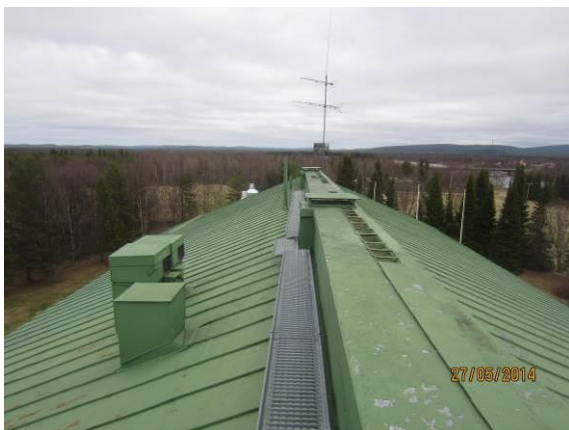
Kuva 29. Yleiskuva päärakennuksen vesikatosta.
