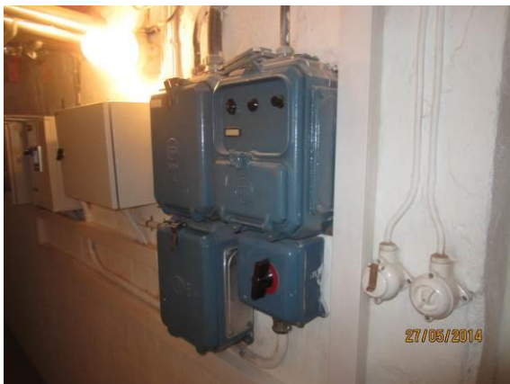
Kuva 60. Asuntolarakennuksen pääkeskus.
