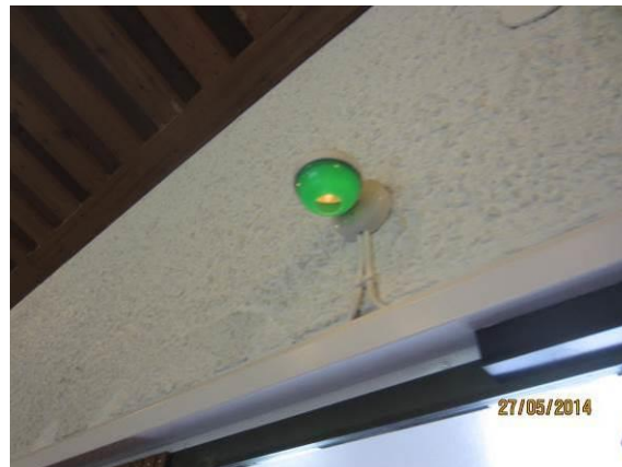
Kuva 74. Aulan poistumistievalaisin.
