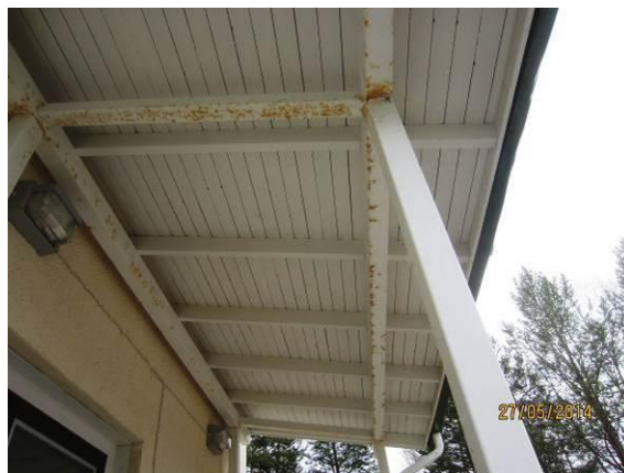
Kuva 7. Lastauslaiturin teräsosissa on ruostetta.
