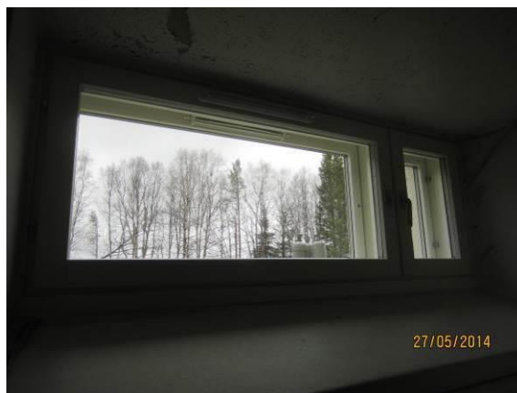
Kuva 24. Yleiskuva, kellarin ikkuna.
