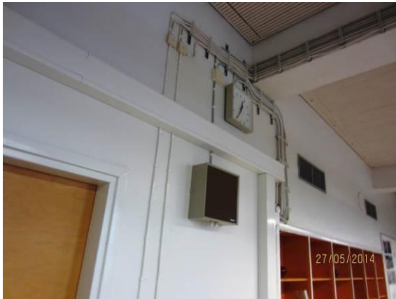
Kuva 78. Luokkatilojen äänentoistojärjestelmä.
