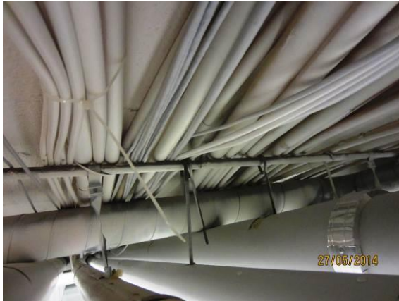
Kuva 54. Päärakennuksen kellarin katossa olevia asennuksia.
