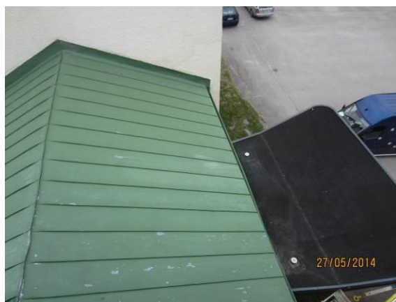
Kuva 32. Yleiskuva yhdysosan katosta.
