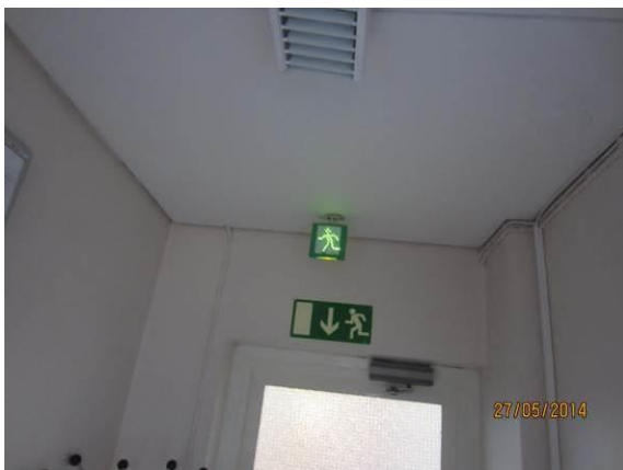
Kuva 75. Uusittu poistumistievalaisin.
