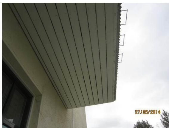
Kuva 28. Parvekkeiden alapinnassa on lautaverhoaus.
