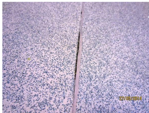
Kuva 40. Keittiön mattosaumat on paikoin rikki.
