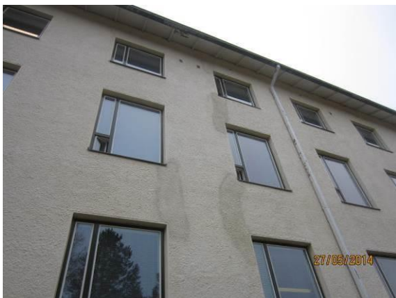
Kuva 21. Yleiskuva, vauriokorjauksia julkisivussa.
