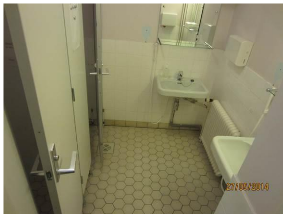
Kuva 46. Yleiskuva, alkuperäiskuntoinen wc.
