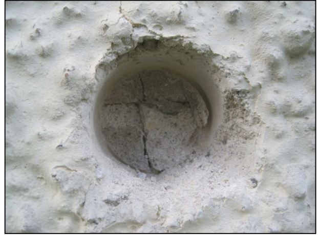
Kuva 15. Pinnoitteet ovat laajalti irronneet alustastaan tai puuttuvat kokonaan (selvitysporaus 16).
