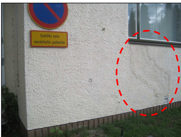
Kuva 6. Julkisivuja on korjattu. Korjaukset on selvästi havaittavissa.
