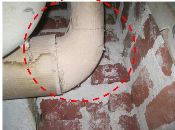
Kuvat 5-6. Asuntolan 1 ja päärakennuksen välisessä putkitunnelissa olevat alkuperäiset osittain purkamattomat putkieristeet sisältävät asbestia
