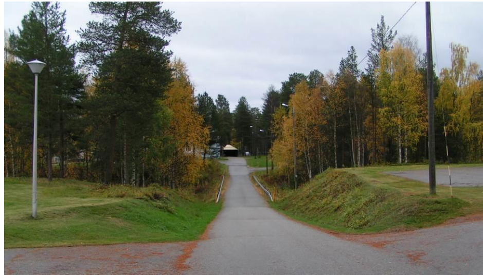
Kuva 22. Rajavartioston asuinalueen silta, näkymä pohjoiseen.
